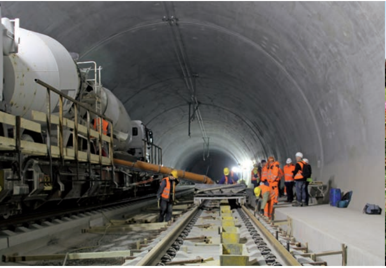
Bau der Fahrbahn im Tunnel 2015
