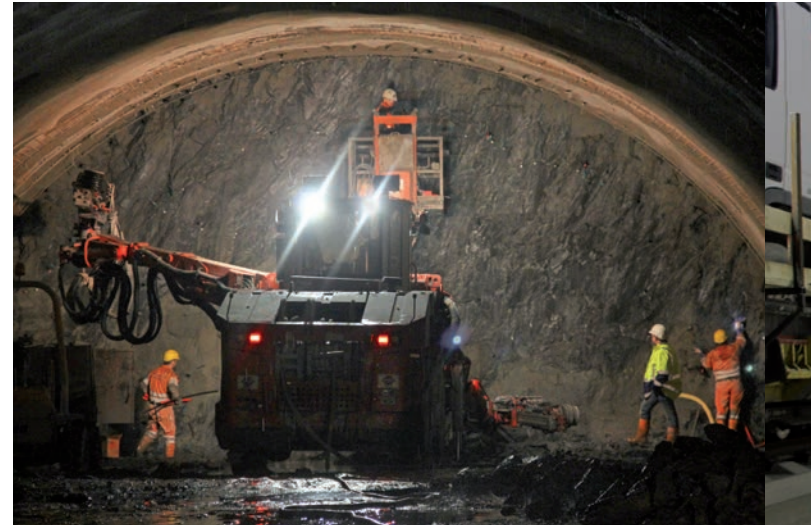
Vortriebsarbeiten an der Ortsbrust 2011
