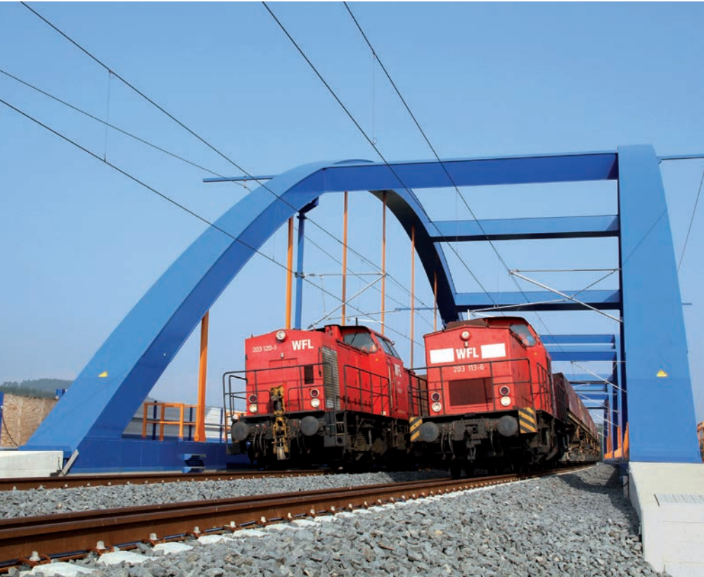
Probbelastung/dynamische Messung der Mainbrücke Wiesen, September 2016
