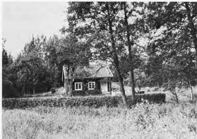
19 SKÄSTA 1:1, 2:1, Björnmyran. Fd torp (I) under Skästa, nu fritidsbostad. Huset uppfört i timmer som rödfärgats, täckt med enkupigt taktegel. Troligen byggt under 1800-talets senare del. Värdefull närmiljö.
