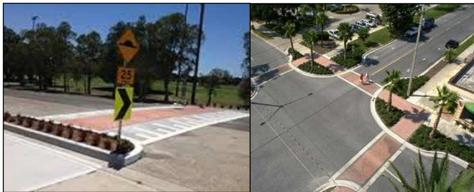
Contoh Penenang Trafik ( Traffic Calming ) Yang Boleh Digunakan Di Kawasan Berhampiran Sekolah Dan Persimpangan
