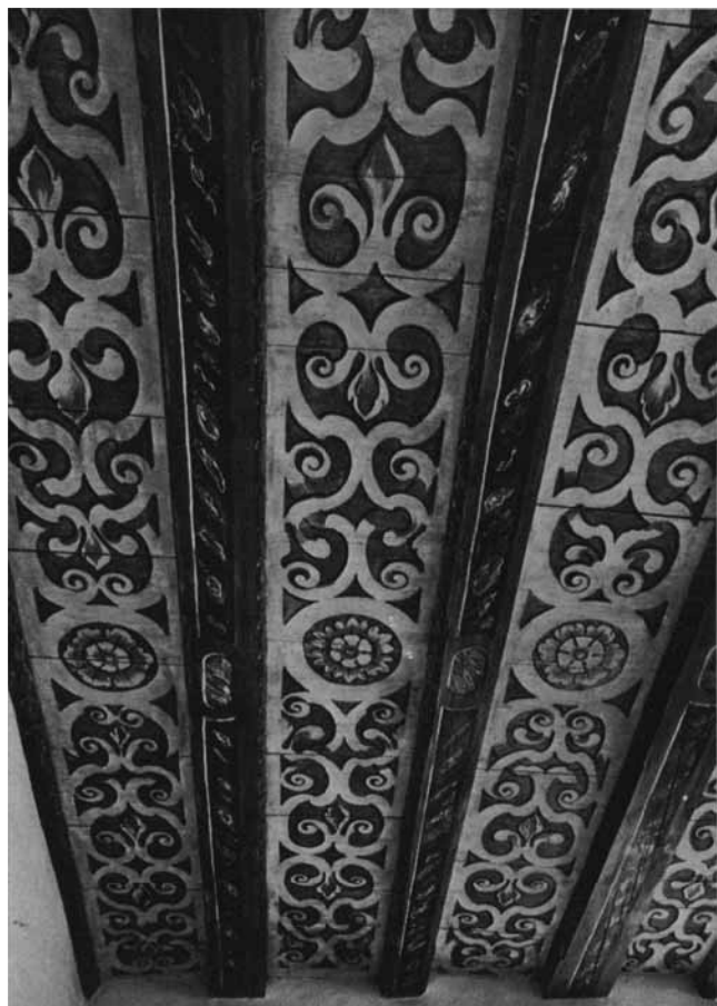
Zollikon. Seestrasse 83. Haus zum «Traubenberg». 2. Obergeschoss. Bemalte Balkendecke im grossen Salon im Westteil, nach der Restaurierung.
