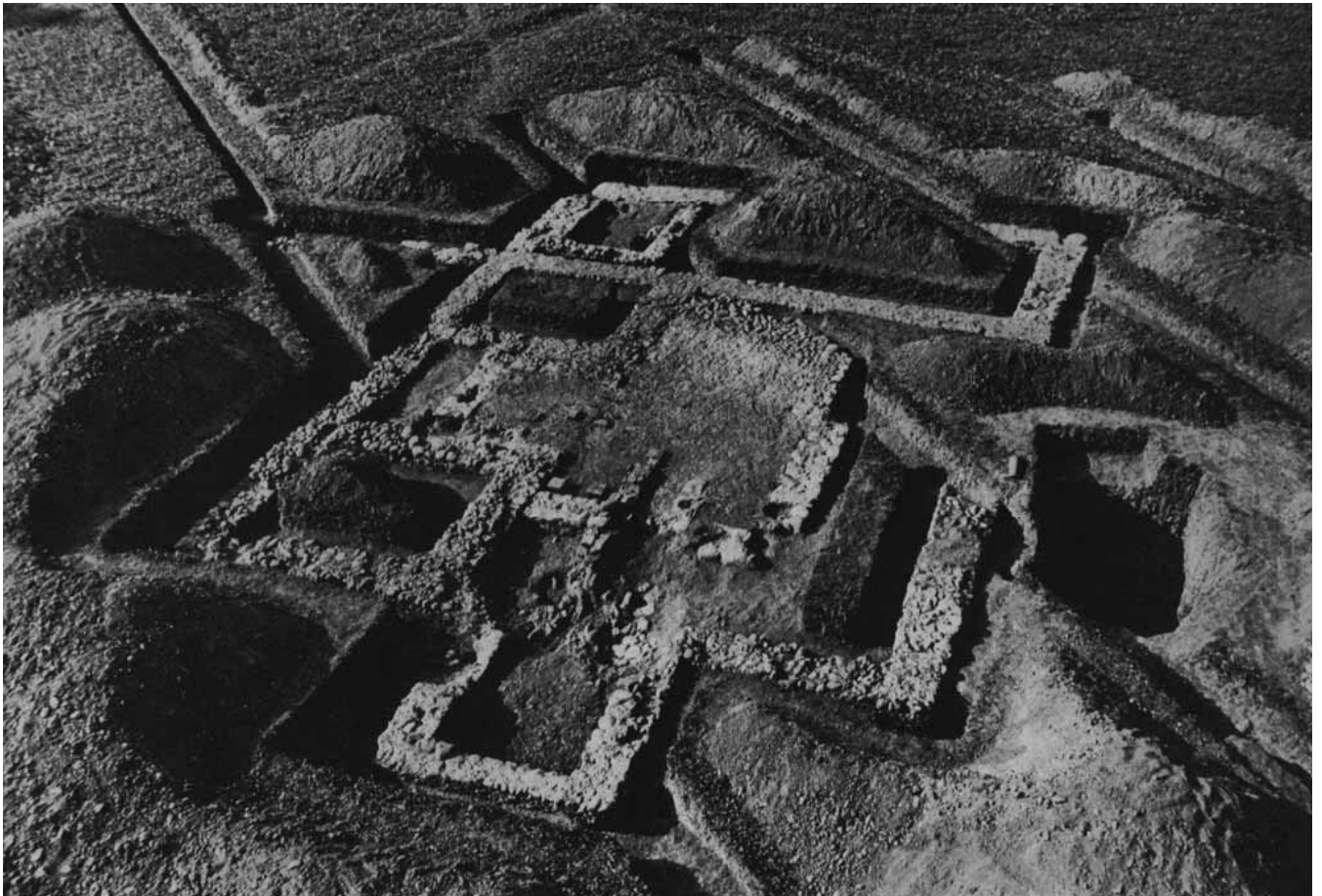
Winkel. Seeb. Gebiet des römischen Gutshofes. Rettungsgrabung 1961. Fundamentreste des Gebäudes G, aus Südosten.
