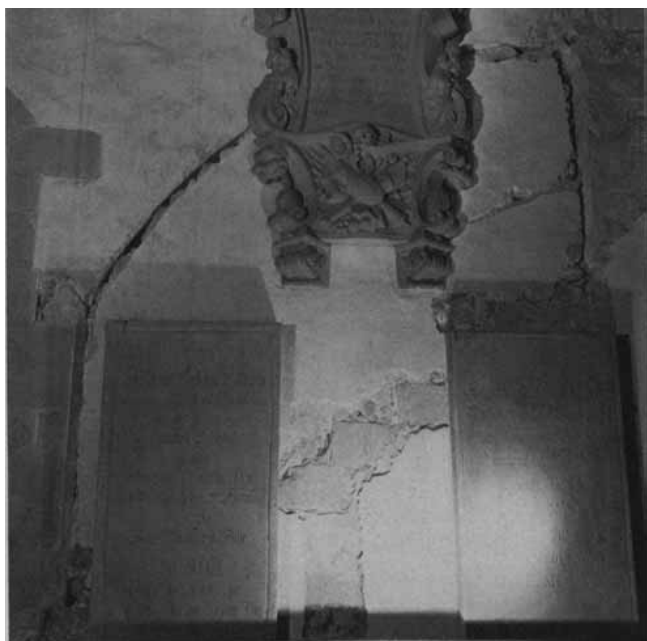
Fraumünster. Vermauerte Treppe in der Nordwand des Querhauses.
