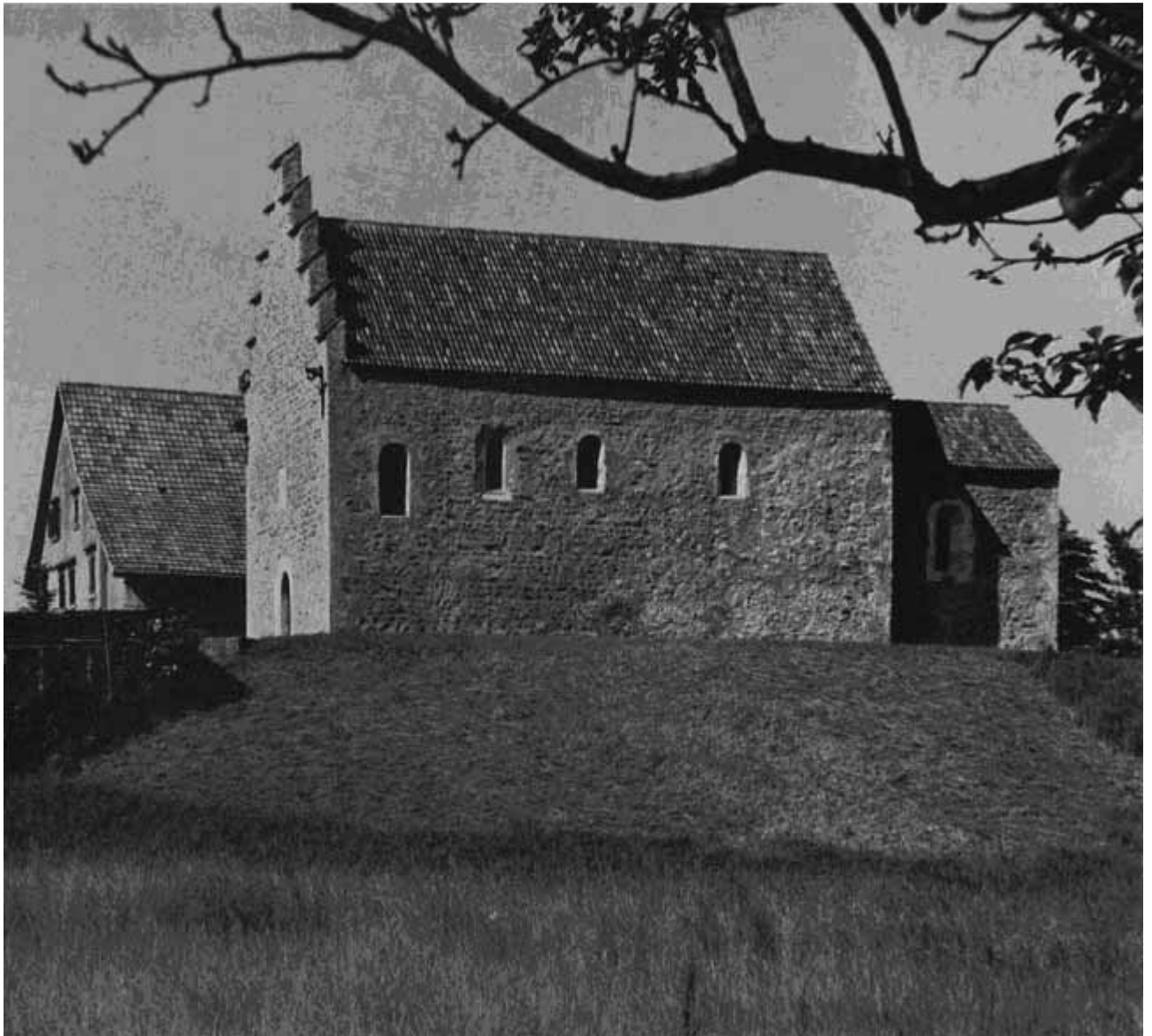
Dübendorf. Gfenn. Ehemalige Lazariterkirche, aus Süden. Nach der Restaurierung 1962/63.
