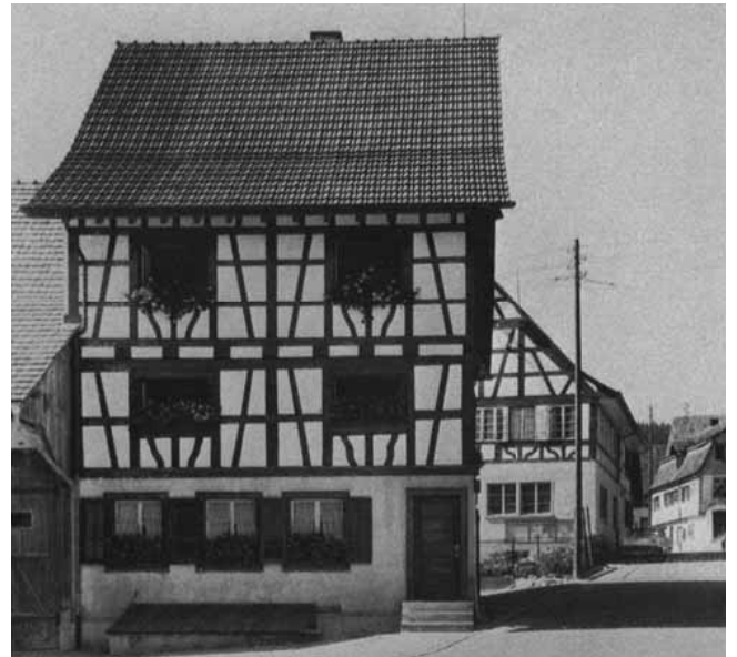
Hüntwangen. Bauernhaus Arnold Meier. Nach der Aufstockung und Renovation.
