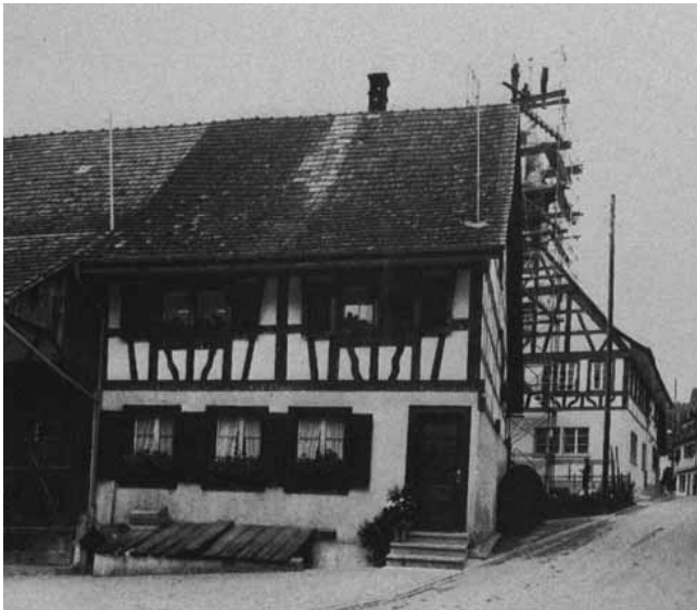
Hüntwangen. Bauernhaus Arnold Meier. Vor der Aufstockung.
