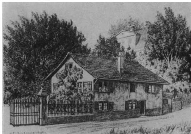
Enge, Brandschenkestrasse 52. Ansicht des jetzt abgebrochenen Hauses von Süden. Zeichnung von H. Hintermeister.
