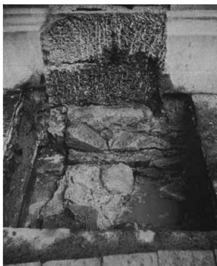
Fraumünster. Strebeböfeler zwischen Querhaus und Nordturm.
