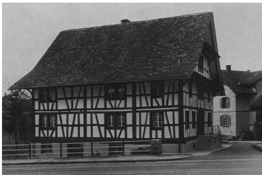
Maschwanden. Ehemaliges Untervogt- beziehungsweise Gemeindehaus. Nach der Gesamtrestaurierung 1965/66.
