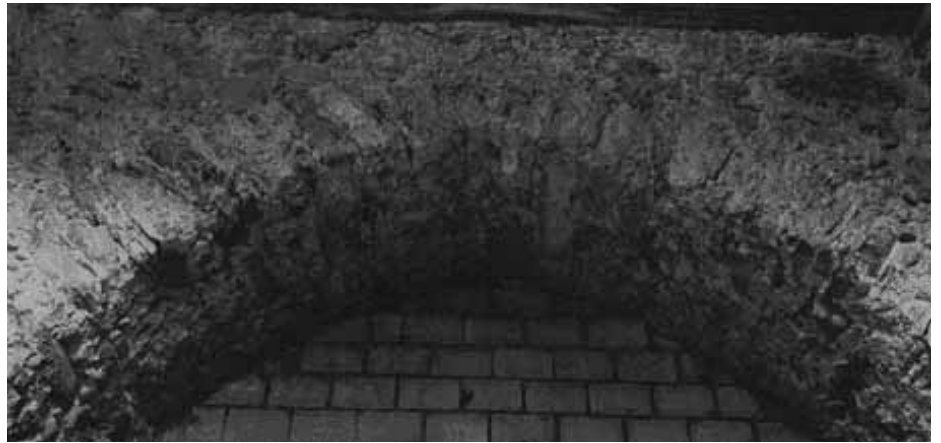
Bassersdorf. Reformierte Kirche. Chorbogen des Chorturmes, aus Osten, nach Abschlagen des Verputzes.
