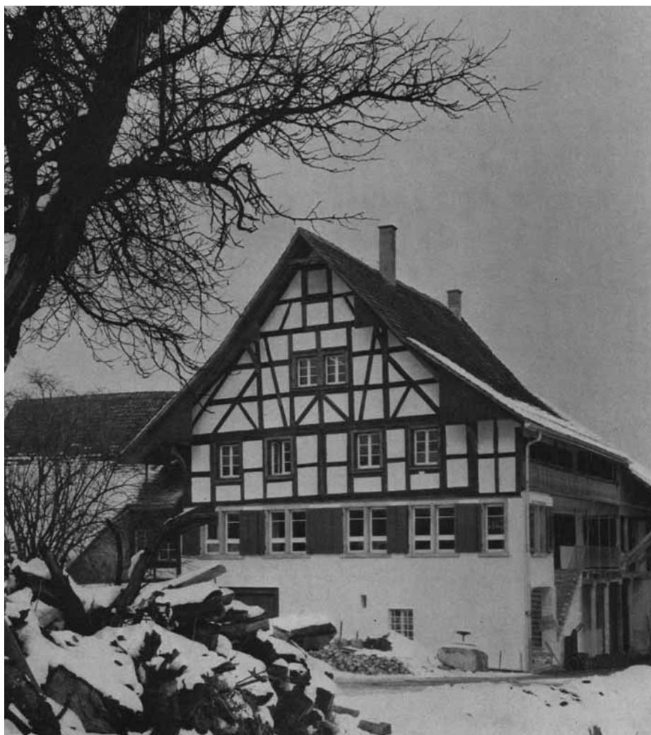
Wydlerweg 19. Mühle Albisrieden nach der Renovation.
