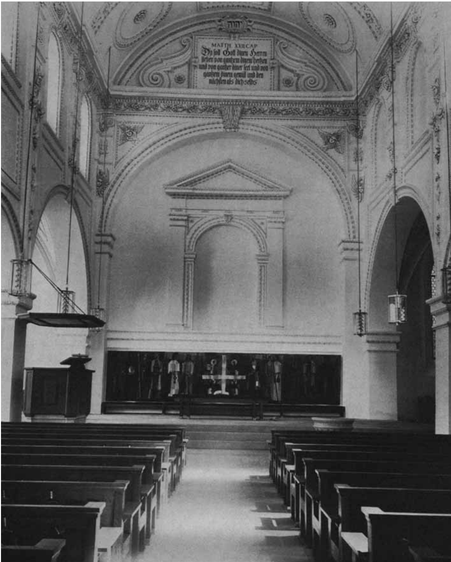
Predigerkirche. Mittelschiff nach der Restauration. Blick nach Osten.
