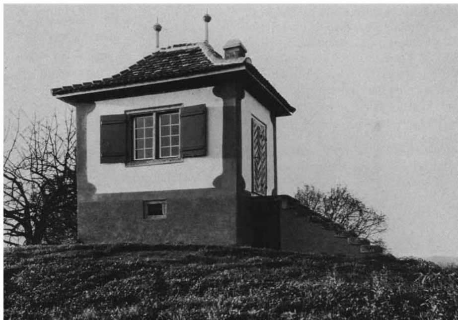
Marthalen. Sogenanntes Guggenbuelhüsli, nach der Restaurierung.
