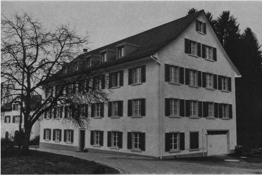
Urdorf. Ehemalige Mühle von 1860. Nach der Renovation.
