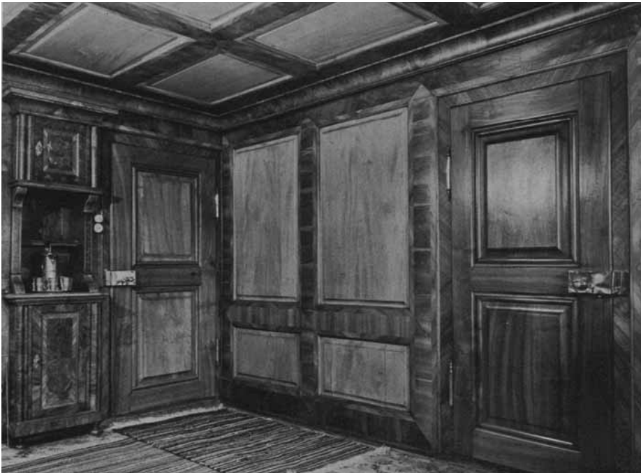
Oberrieden. Alte Landstrasse 30. Haus zur «Alten Trotte». Täferstube, vor dem Abbruch ausgebaut und im Neubau Spielhofweg 9 wieder verwendet.
