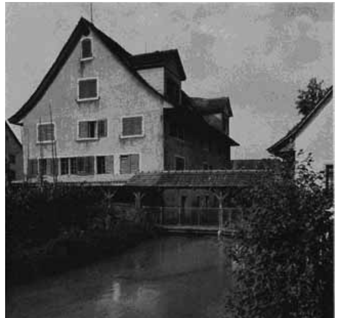
Adliswil. Sihltalstrasse Alte Mühle, abgebrochen 1965.
