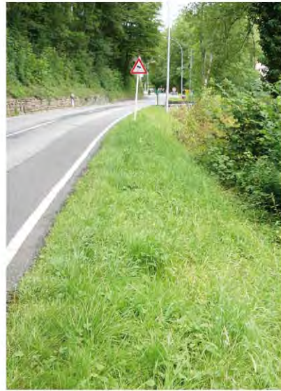
Istzustand: unwegsame Böschung
