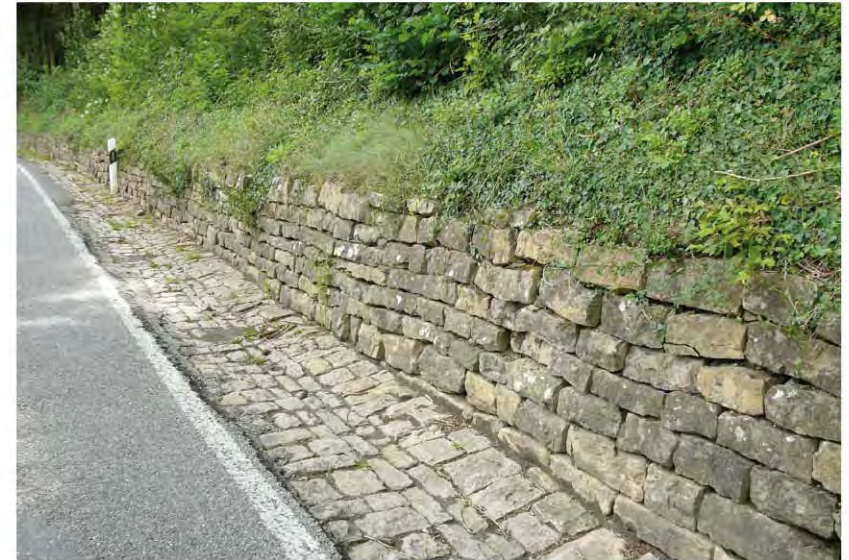
Trockenmauer als Hangbefestigung
