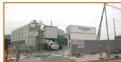
水泥廠 Cement Works
