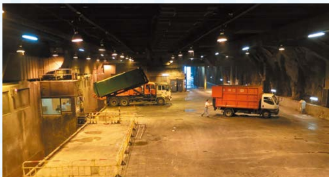
港島西廢物轉運站-香港發展岩洞的例子 ©土木工程拓展署
