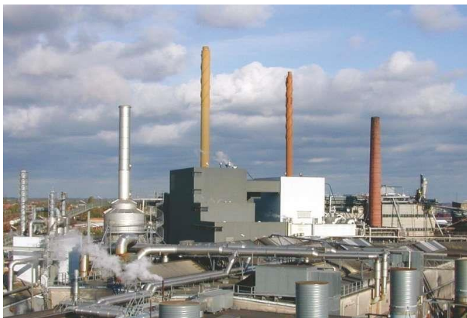
Figur 12: De to blokke på Køge Kraftvarmeværk ses med de to høje skorstene i midten.
