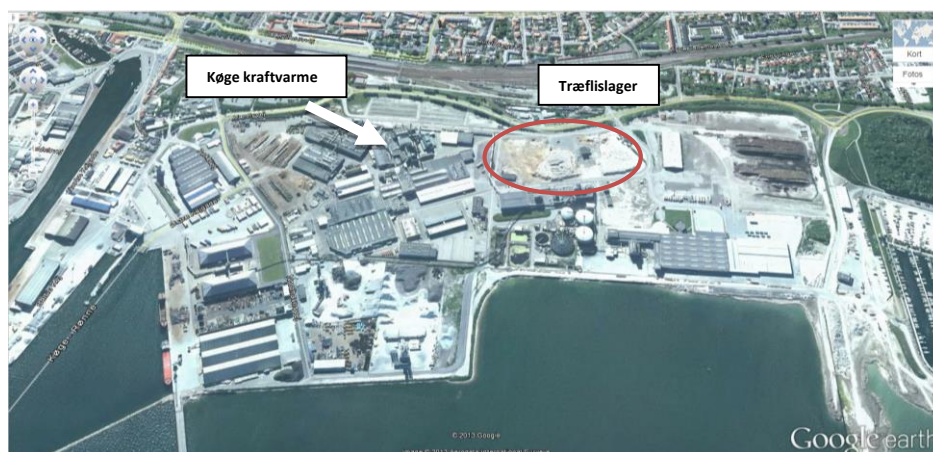
Figur 13: Køge Kraftvarmeværk og Junckers Industrier i Køge. Kraftvarmeværket fyres hovedsageligt med træflis og træaffald (træstøv) fra gulvproduktionen på Junckers fabrikker. Den røde cirkel på billedet markerer kraftvarmeværkets eget træflislager.
