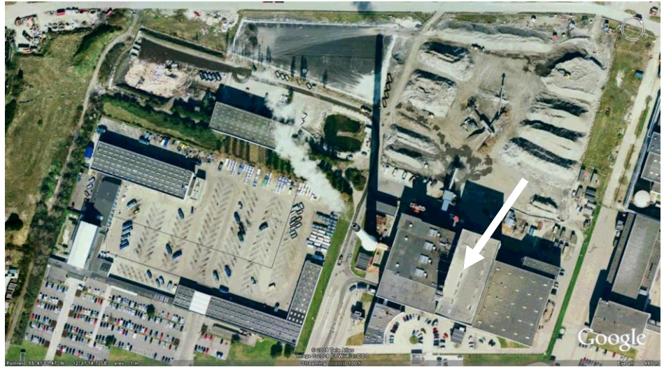
Figur 16: Amager Ressource Center er placeret sydvest for Amagerværket. Pilen markerer bygningen med de fire identiske ovnlinjer, som kan operere uafhængigt af hinanden.
