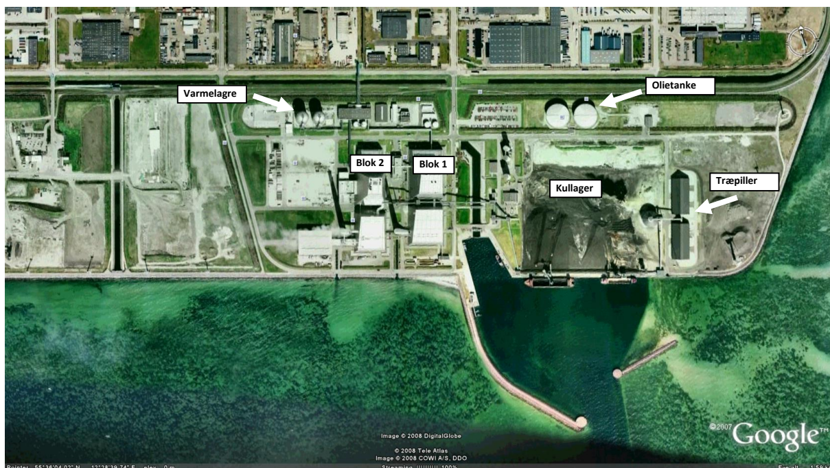
Figur 7: Avedøreværket. Blok 1 (1990) er et udtagsanlæg, som er den højre blok på fotoet ovenfor. Turbiner, generator og kondensator samt kedel er placeret i den øverste bygning. I den nederste bygning findes askeudskiller og afsvovlingsanlæg. Blok 2 (2002) er placeret til venstre for blok 1 på fotoet. Turbinerne (øverst, øverste bygning) bliver forsynet med damp fra hovedkedlen (øverste bygning), fra gasturbiner (sidebygning til øverste bygning) og biomassekedel (halm), som er placeret nederst i nederste bygning. I nederste bygning er askeudskiller og afsvovling ligeledes placeret. Nederst til venstre oplagres halm. Til højre for blokkene opbevares kul. Længere til højre opbevares aske. På grunden til venstre for de to blokke er der mulighed for placering af en tredje blok. Der er gode adgangsveje for landtransport via Køge Bugt-motorvejen. Havnens dybde på 7 m, begrænser adgangen for søtransport. Varmelageret ses øverst til venstre. Træpiller opbevares i de to langtidslagre og i arbejdssiloen (korttidslager), som ses til højre i billedet. Olietankene er de 2 hvide cirkler øverst i midten. Olien kan anvendes til opstart og i hovedkedlen.
