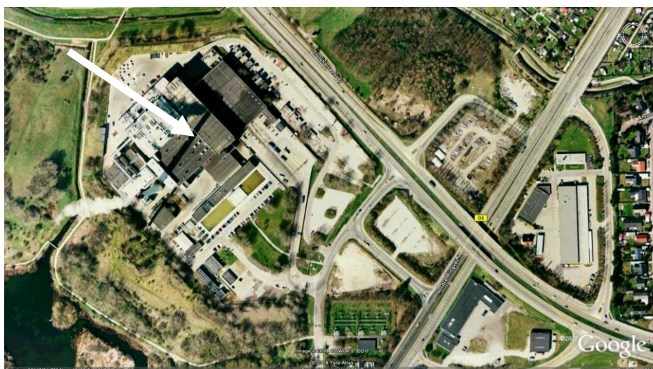
Figur 18: Vestforbrændings anlæg i Glostrup består af to ovnlinjer (bygningen markeret af pilen). Anlæg 5 tager 26 tons pr. time mens anlæg 6 tager 35 tons pr. time. Affaldet læsses af i en 100 m lang, 10 m bred og 20 m dyb affaldstragt som er placeret i bygningen øverst til højre.
