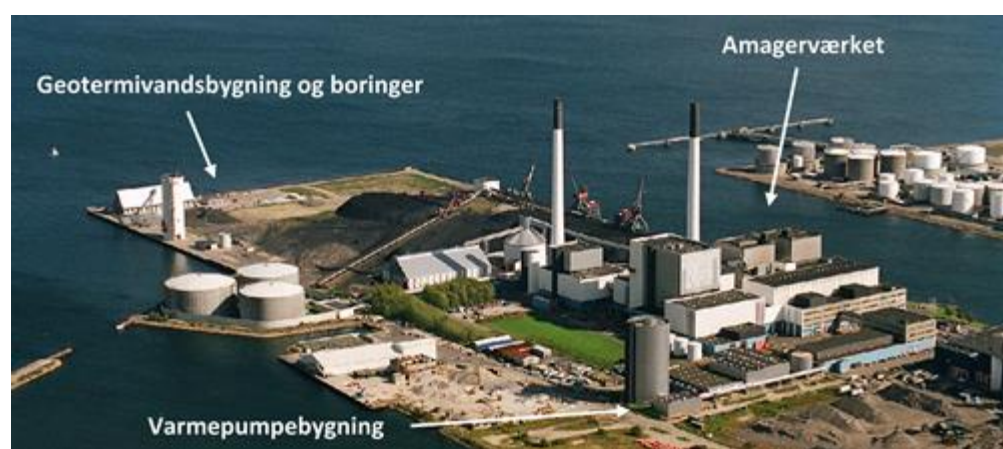
Figur 20: Det geotermiske demonstrationsanlæg Margretheholm på Amager
