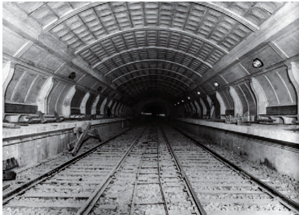
1— Obras de construcción del metro Transversal, ca. 1920. 2— Andén de una de las primeras estaciones del metro Transversal, todavía en construcción, ca. 1924.
