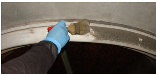
Limpeza de la acumulación de polvo
