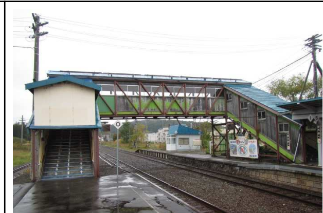
軟弱地盤上の乗換跨線橋
