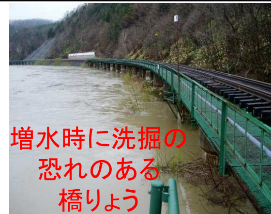
(例: 宗谷線 糠南・雄信内間 問平陸橋)
