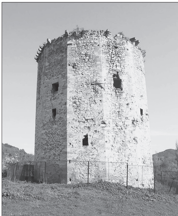
Чоргунская башня. Вид с северо-запада. Современное фото
