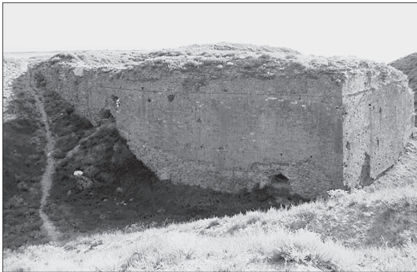
Одна из батарей на Перекопском валу. Современный вид
