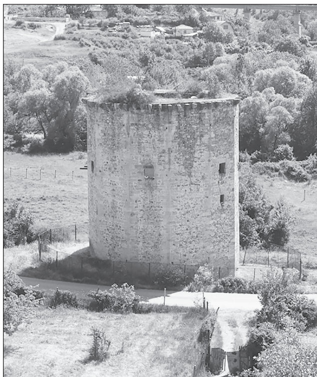
Чоргунская башня. Вид с северо-востока. Современное фото
