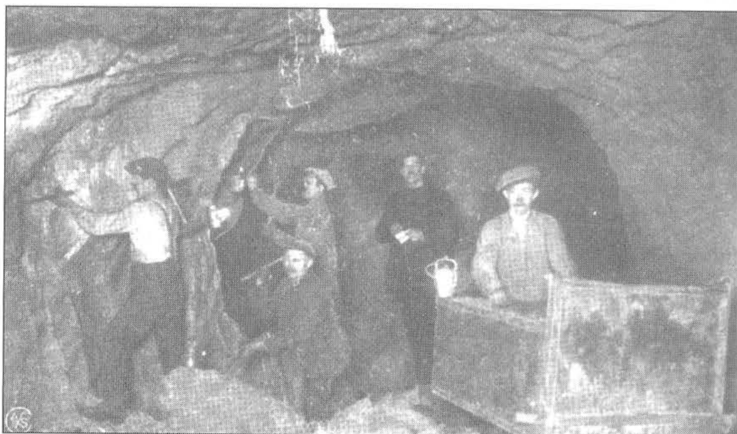
Gruvearbeidere i virksomhet inne i en av gruvne på Ertelia.
