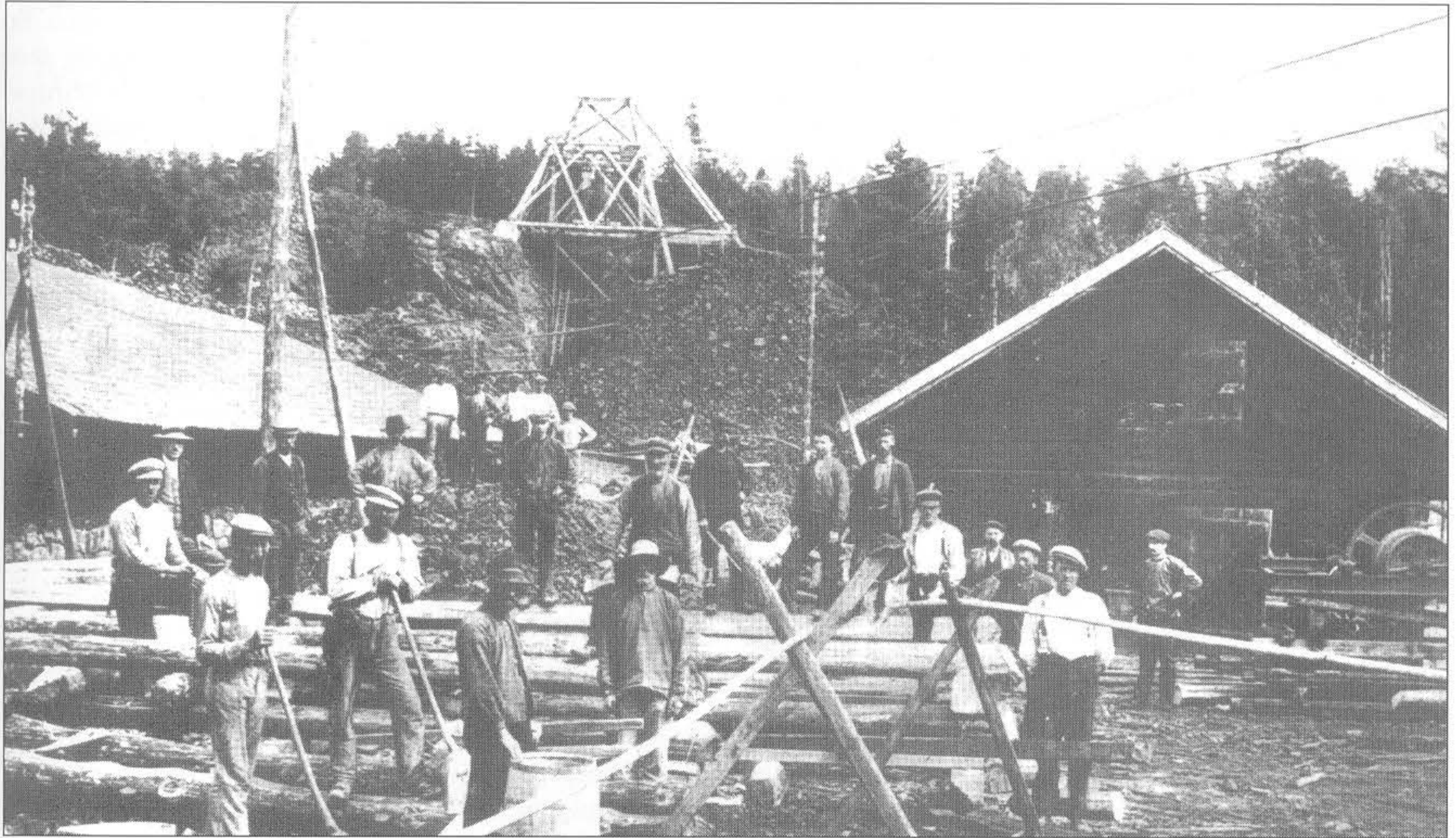
Ringerike Nikkelverk ved Aasterudtjern på Tyrstrand. Arbeidere foran Ertelia gruve nr. 2. Midt på bildet i bakgrunnen ser vi heisanordningen til gruve, som var den største ved Ertelia. Til venstre skeidhuset, der malmen ble sortert etter at den kom fra gruve. Bildet er tatt i perioden 1912-1920. (Buskerud Fylkesfoto).
