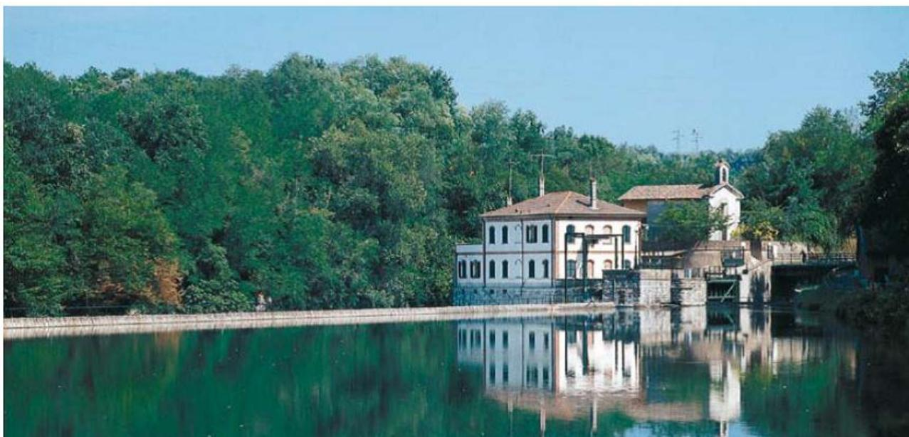
Il canale derivatore ha l'imbocco a quota 180,20 m s.l.m. ed è navigabile nel primo tratto, lungo 690 m. Questo canale mantiene il tracciato dell'antico naviglio e fu ampliato dalla Edison per adeguarlo alla portata d'acqua necessaria per l'impianto. Il canale è all'aperto ed ha sezione rettangolare.
