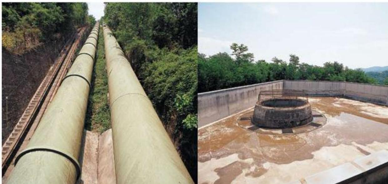
Dopo tale congiunzione, la galleria prosegue per ~800 m fino alla località Oppilo, dove si trova il pozzo piezometrico, dotato in testa di una vasca d'espansione, a cui fanno seguito le condotte forzate che convogliano le acque verso la Centrale..
