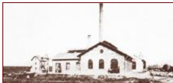
Uzina Hidroelectrică Grozăvești (1890)
