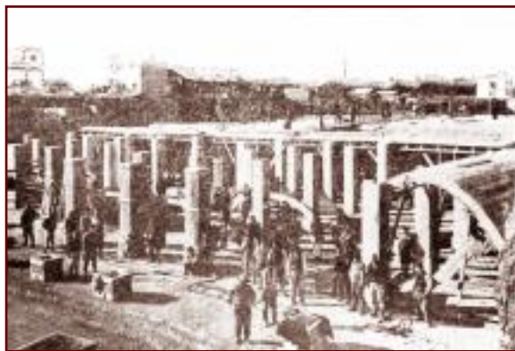
Rezervorul de apă de la Cotroceni în construcție (1890)
