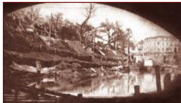
Lucrări de acoperire a Dâmboviței (1934)
