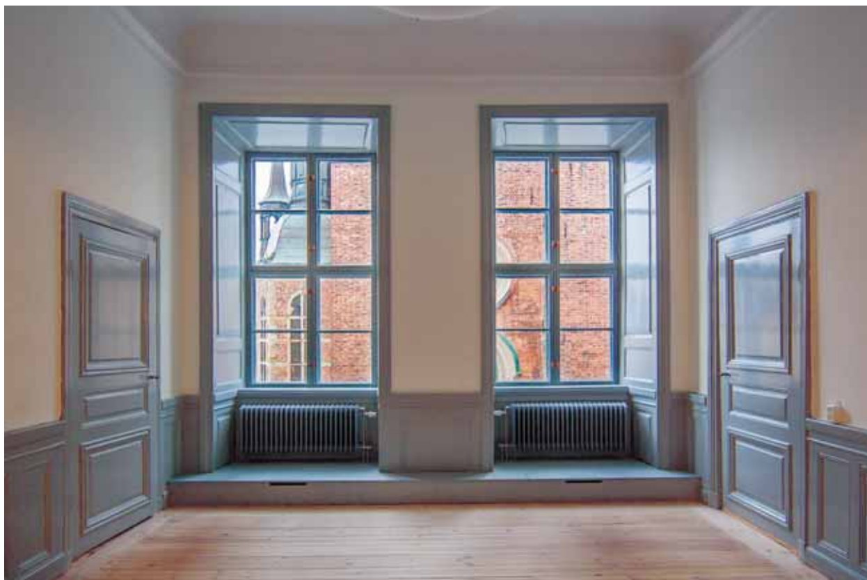
Rum 4409 i våningen en trappa upp i Sparreska palatset strax efter renoveringen, 2011.
