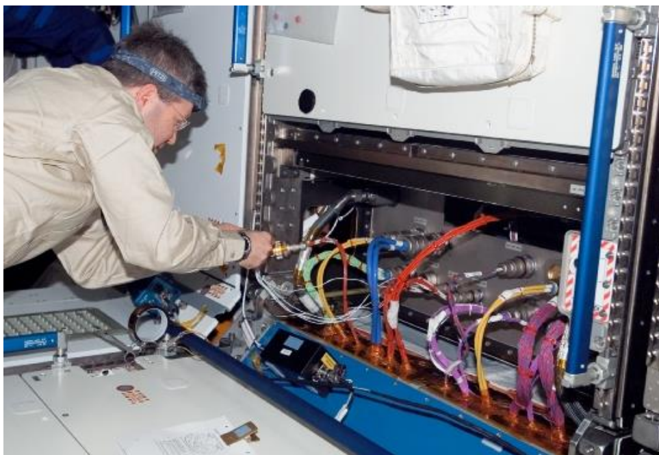
図3.4-4 ハーモニーの電力・通信配線のトラブルシューティング（故障箇所の究明） (NASA)
