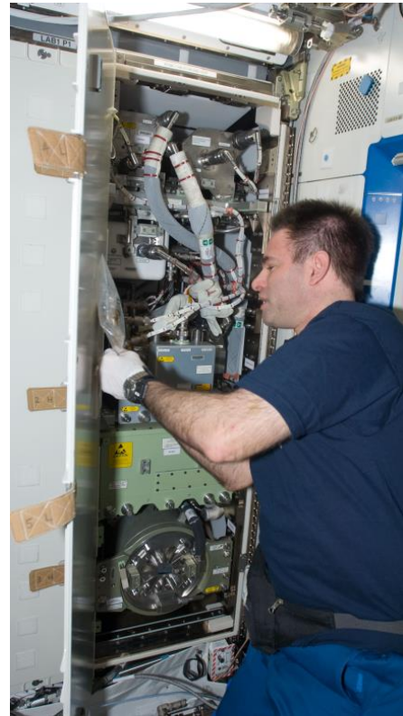
図4.2-2 米国の酸素生成装置(OGS)(NASA)
