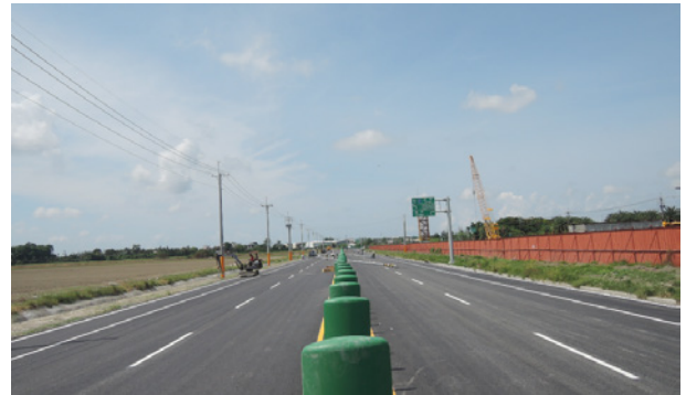
圖 4 改道便道現況照片
