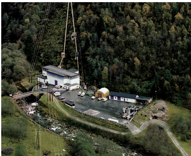
Gamle K2 med tilhøyrande rørgater skal erstattast med ein kraftstasjon inne i fjellet.
