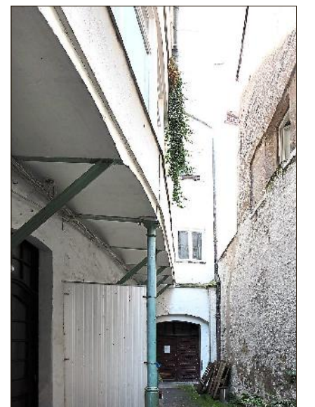
Gusseiserne Säulen tragen den Anbau des Rückgebäudes.
