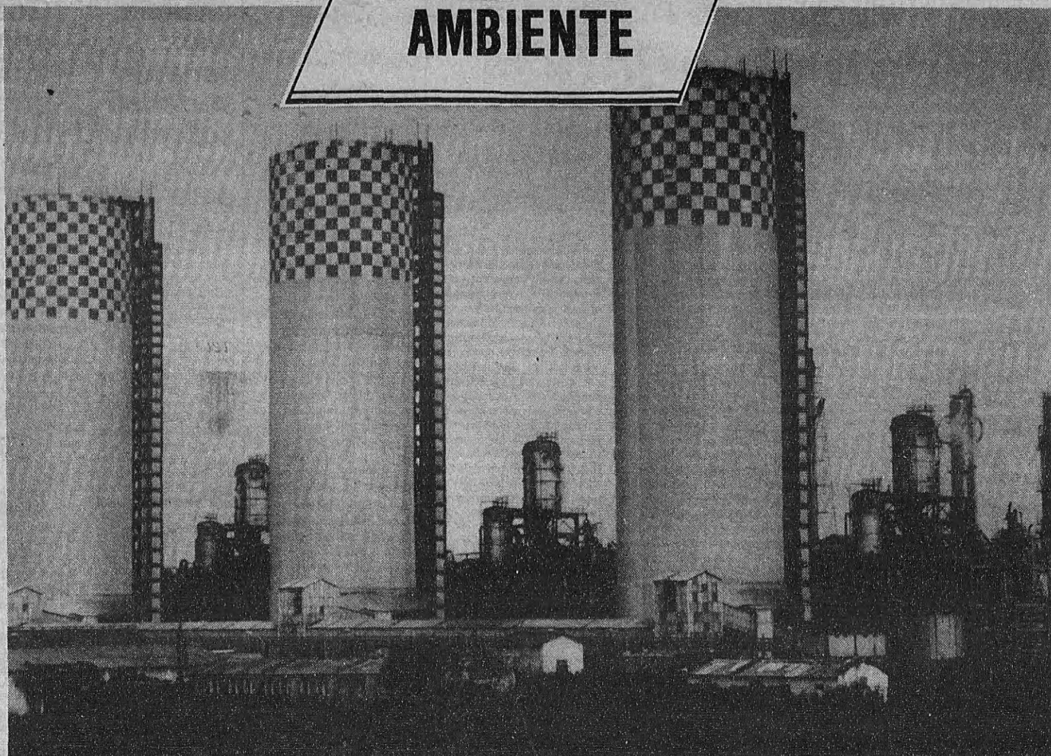
Nelle foto: Alcuni impianti SNAM-Progetti S.p.A.
