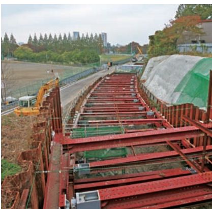
川内駅付近も開削工法で工事が進む。
