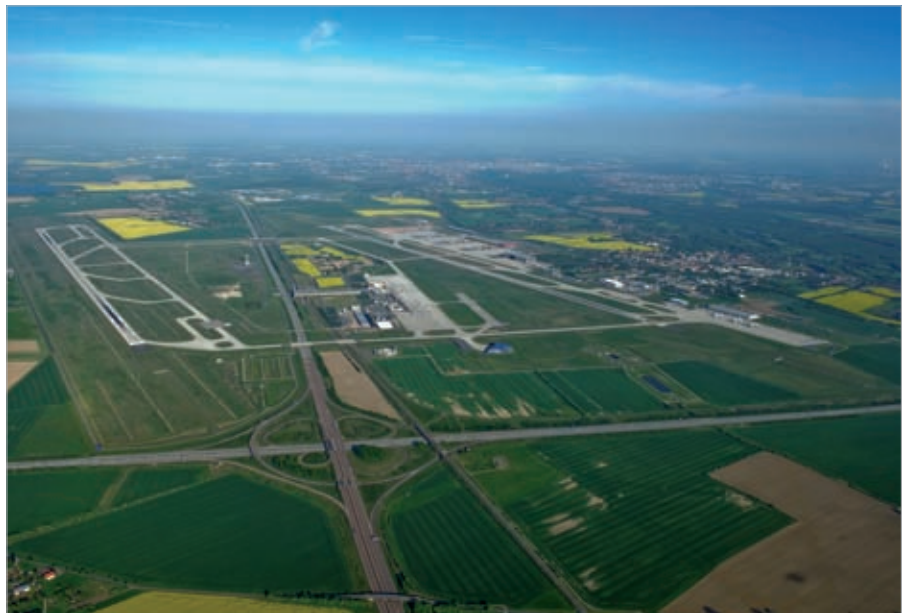
Abbildung 8: Luftaufnahme des Flughafengeländes Leipzig/Halle / im Vordergrund das Schkeuditzer Kreuz mit den Bundesautobahnen 9 und 14 (© Uwe Schoßig)
