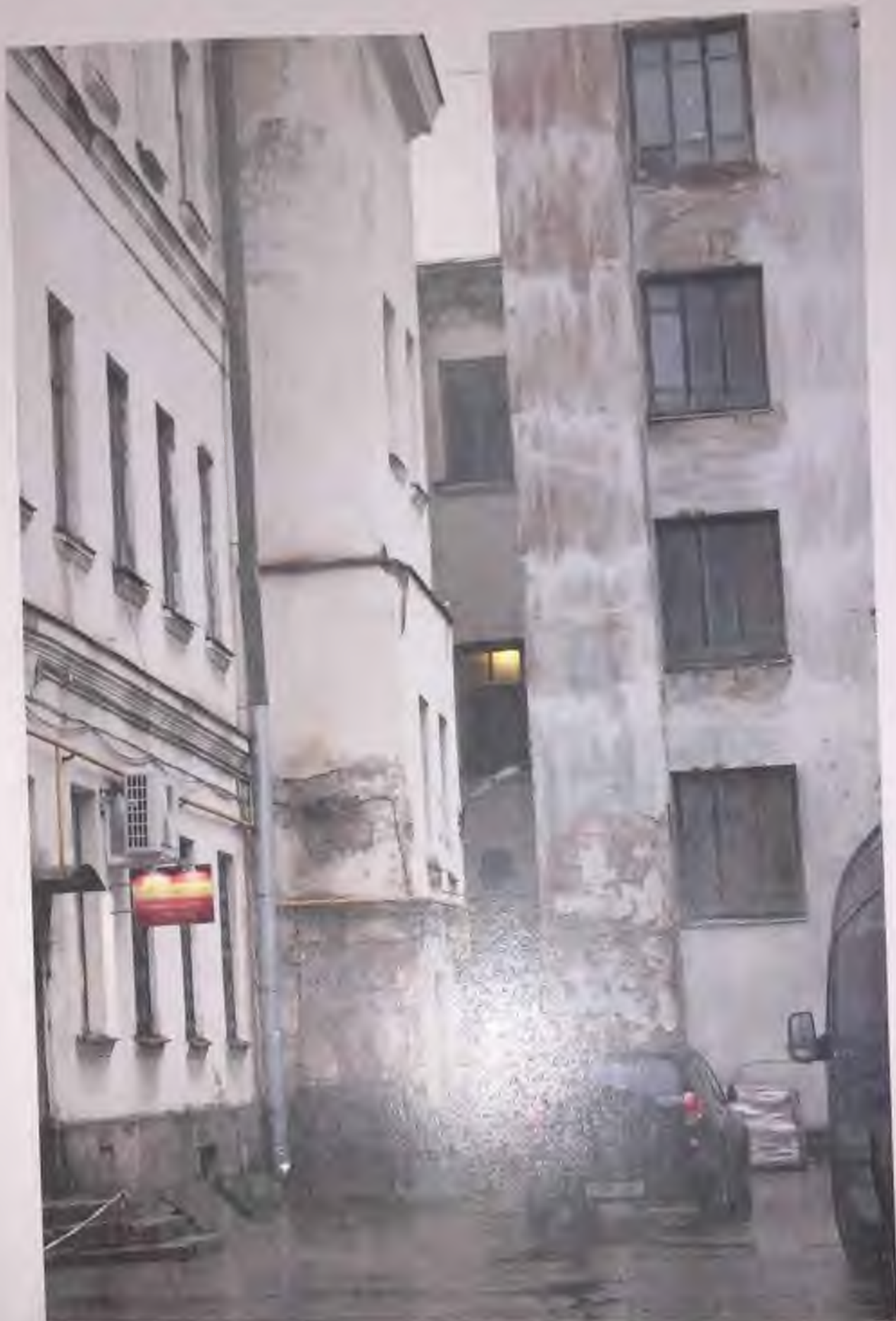
Фото 6. Северный фасад здания. Фрагмент. Автор фото: Маланичева Г.И. 30.11.2016 г.
