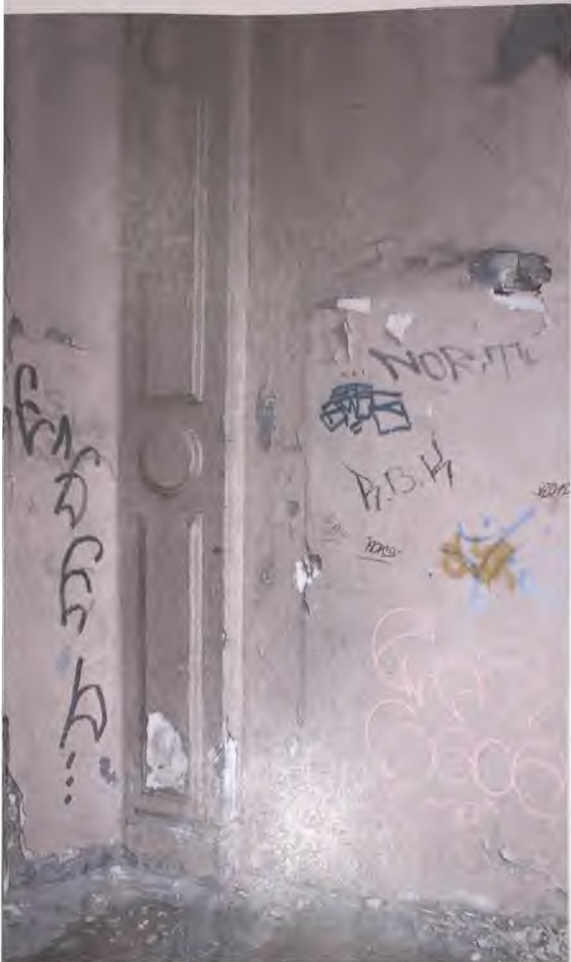
Фото 2.8. Западный фасад здания. Фрагмент. Автор фото: Маланичева Г.И. 30.11.2016 г.
