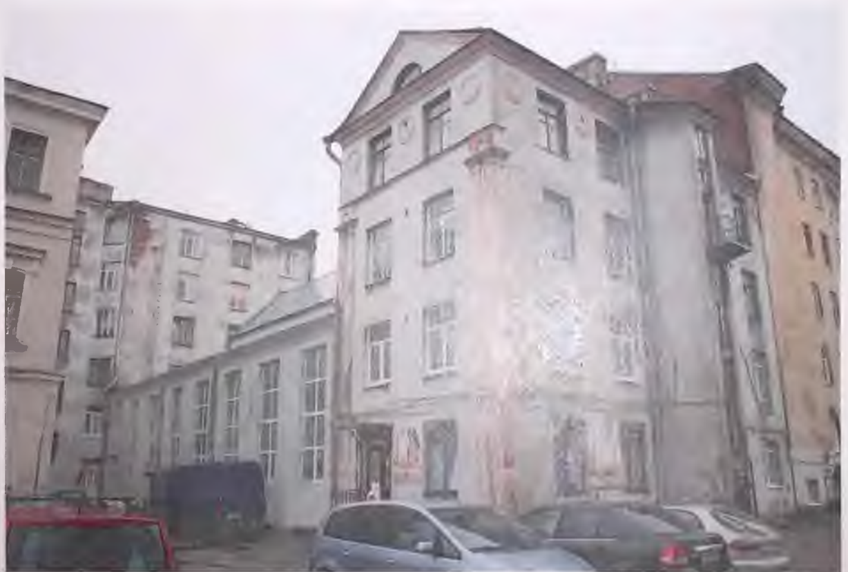
Фото 3. Северный и восточный фасады здания. Фрагмент. Автор фото: Маланичева Г.И. 30.11.2016 г.
