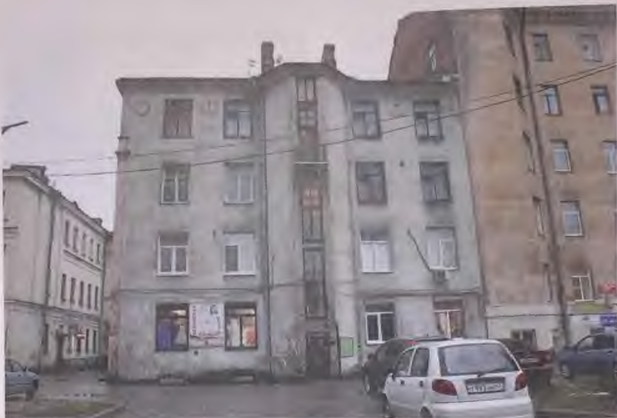
Фото 5. Северо-западный фасад здания. Автор фото: Маланичева Г.И. 30.11.2016 г.
