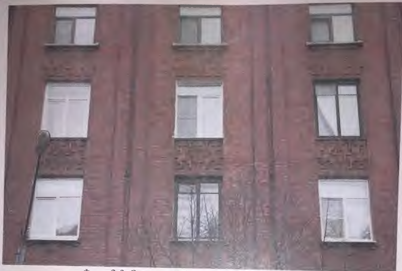
Фото 2.3. Западный фасад здания. Фрагмент. Автор фото: Маланичева Г.И. 30.11.2016 г.
