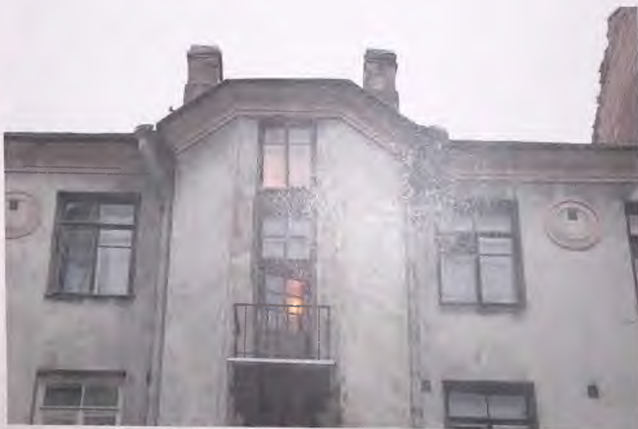
Фото 5.1. Северо-западный фасад здания. Фрагмент. Автор фото: Маланичева Г.И. 30.11.2016 г.
