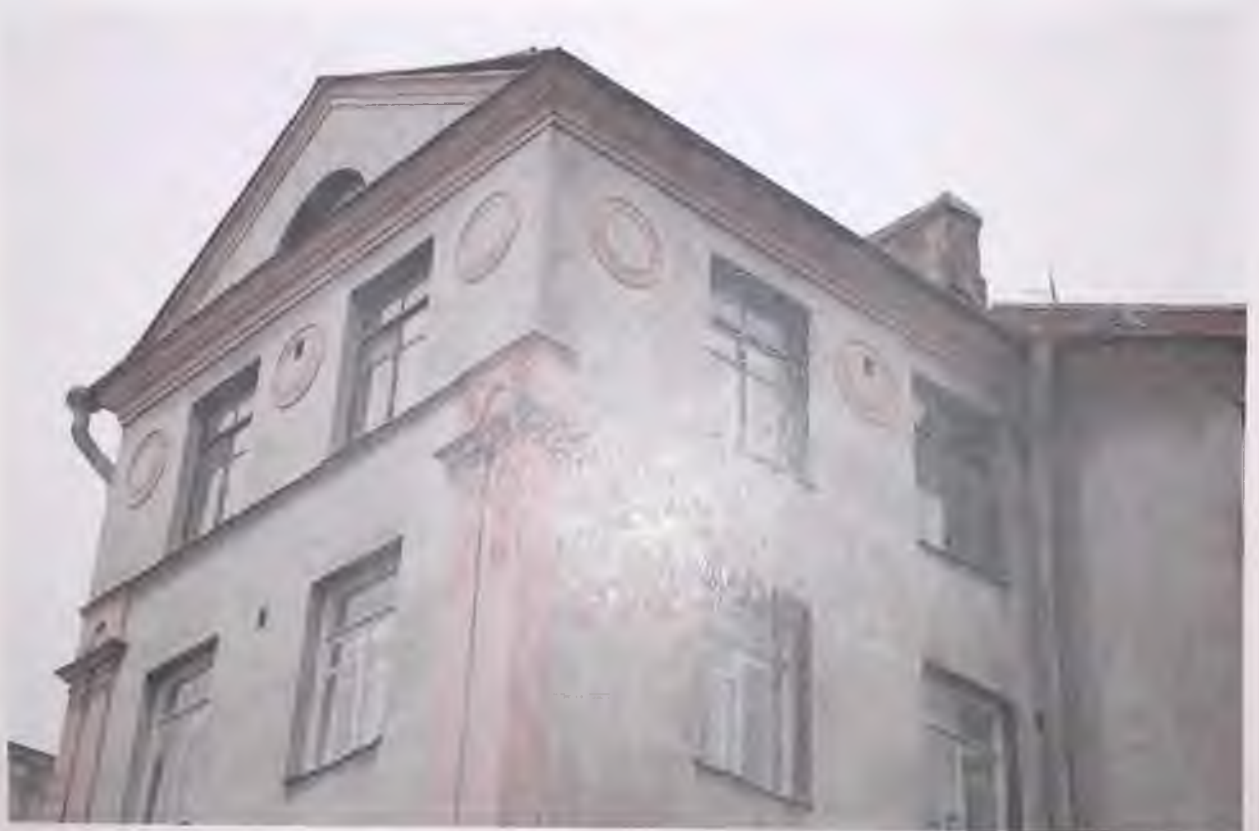
Фото 3.2. Северо-восточный фасад здания. Фрагмент.. Автор фото: Маланичева Г.И. 30.11.2016 г.
