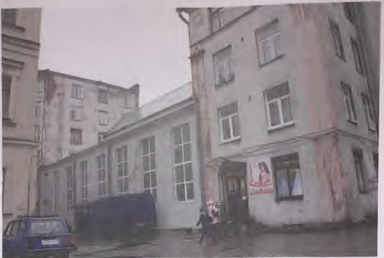
Фото 3.1. Северо-восточный фасад здания. Фрагмент. Автор фото: Маланичева Г.И. 30.11.2016 г.
