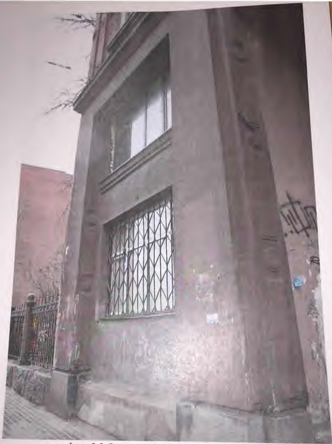
Фото 2.5. Западный фасад здания. Фрагмент. Автор фото: Маланичева Г.И. 30.11.2016 г.
