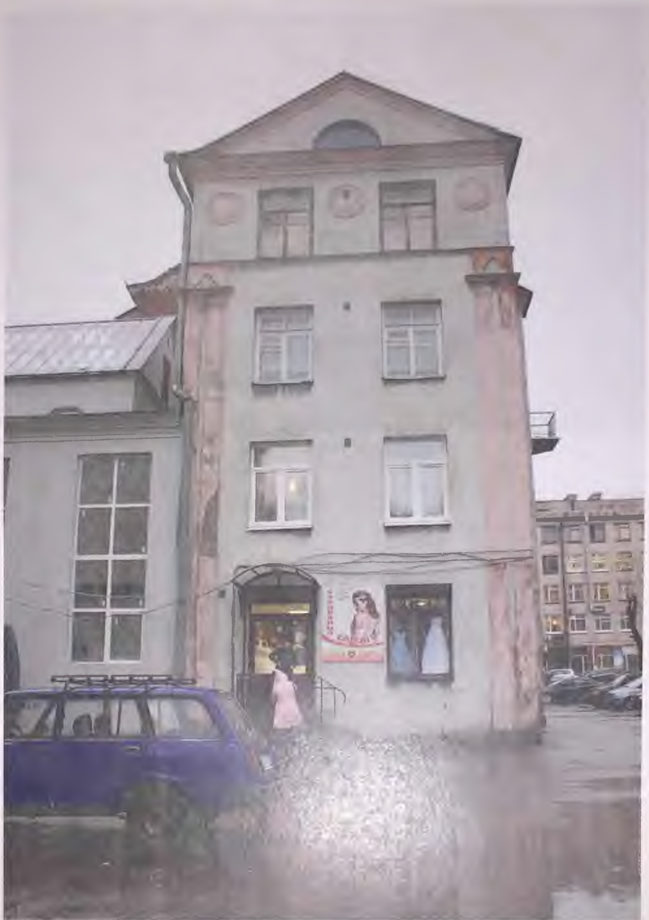
Фото 4. Восточный фасад здания. Фрагмент. Автор фото: Маланичева Г.И. 30.11.2016 г.
