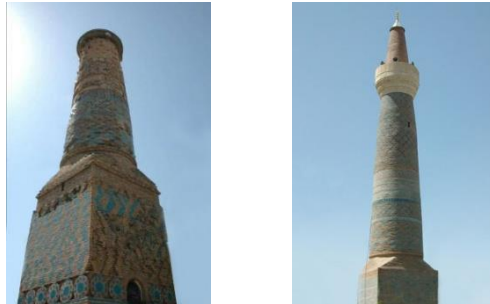
Foto5. Siirt Ulu Camisinin minarəsi (bərpadan əvvəl və sonra)
