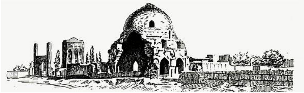
Foto 1. Səlcuqlu- Atabəylərin saray kompleksi-Cümə camii (Ulu Cami), arxada Qoşa minarə, Möminə xatun türbəsi. Memar Əcəmi Əbubəkir oğlu Naxçıvani (Alman memarı Yakobstal tərəfindən XIX əsrdə çəkilmişdir)
