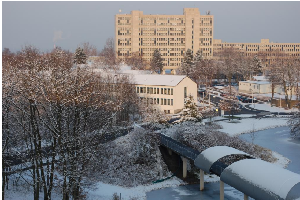
Abb.: Blick aus Gebäude 650 (Fü L)
