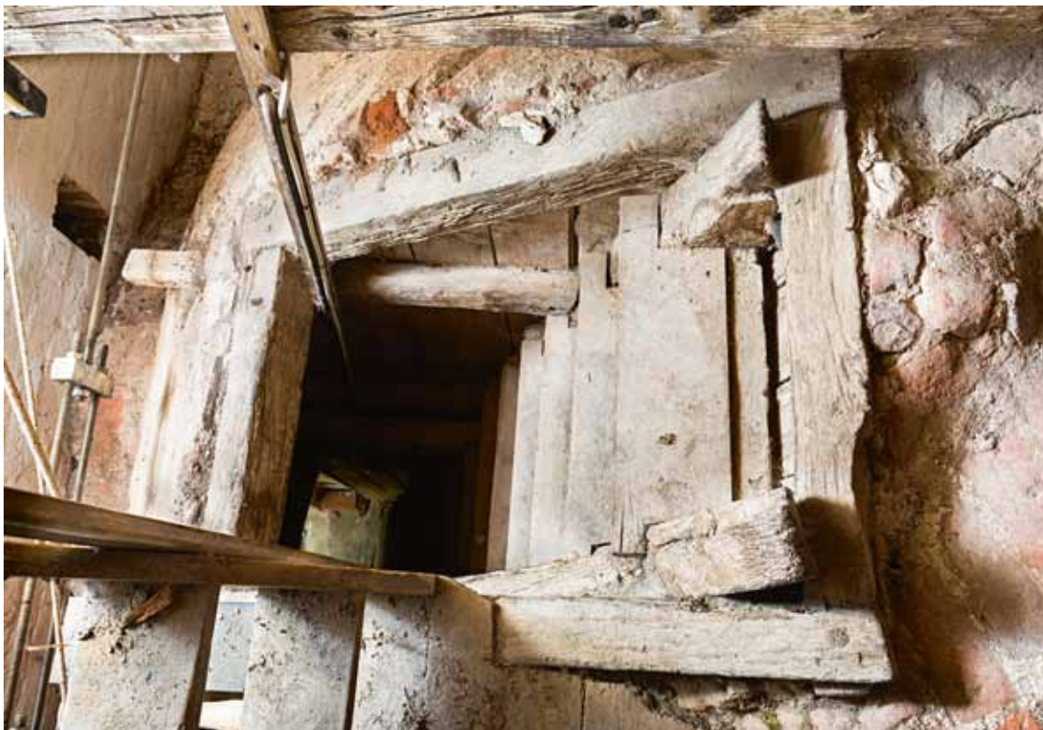
Fig. 16. Trappe til tårnets øvre stokværk med luge gennem tårnhvælvets nordkappe (s. 3666). Foto Arnold Mikkelsen 2015. – Stairs to upper storey of tower with hatch through north severy of tower vault.
