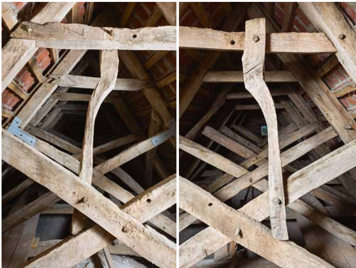
Fig. 23–24. Klokkeophæng(?) i tagværket midt over det romanske skibs østre hvælvfag (s. 3672). Foto Arnold Mikikelsen 2015. 23. Set mod vest. 24. Set mod øst. – Bell suspension(?) in roofing midway across east vault severy of Romanesque nave. 23. Looking west. 24. Looking east.
