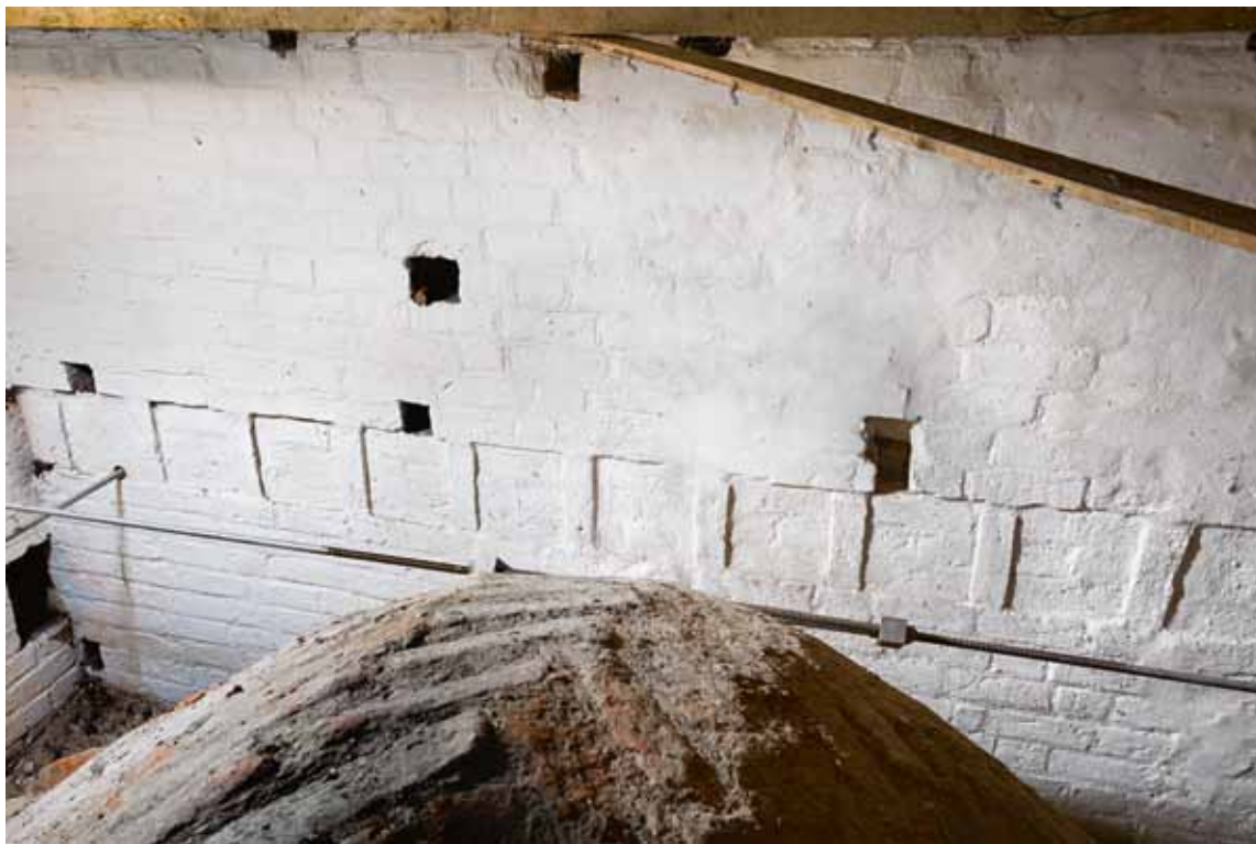
Fig. 7. Skibets vestforlængelses gavlvæg med blændingsfrise (s. 3658) samt tårnets nordøsthjørne med bjælkehul (s. 3662). Foto Arnold Mikkelsen 2015. – Gable of western extension of nave with recess frieze.
