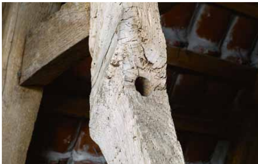
Fig. 22. Klokkeophæng(?) med nord-sydgående, vandret gennem boring (s. 3672). Foto Arnold Mikkelsen 2015. – Bell suspension(?) with north-south horizontal drilling.
