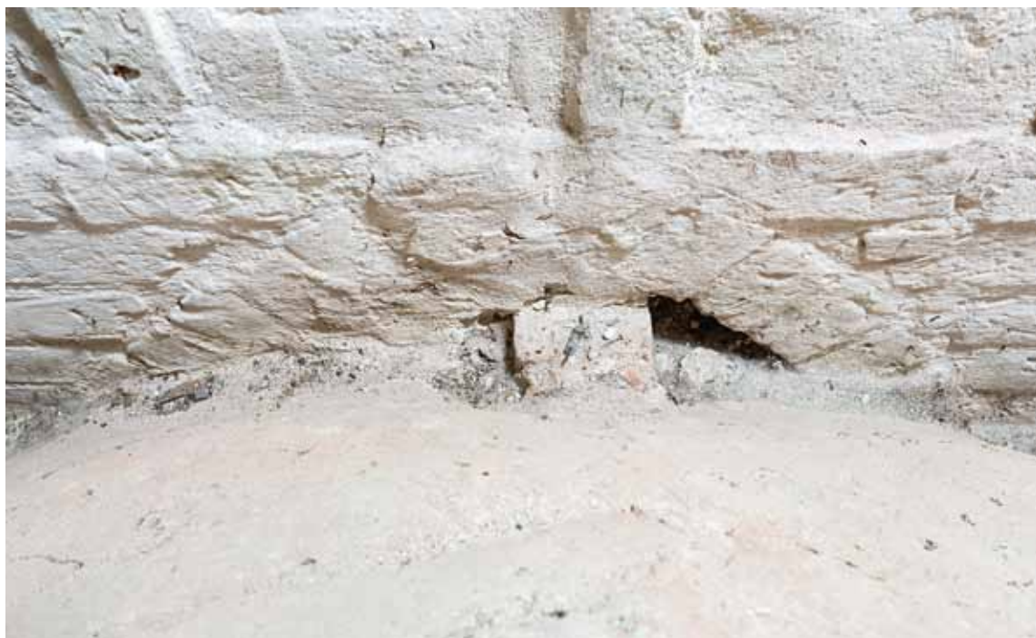
Fig. 6. Rester af et oprindeligt (†)vindue i vestforlængelsens vestgavl (s. 3658). Foto Arnold Mikkelsen 2015. – Remains of an original (†)window in west gable of western extension.
