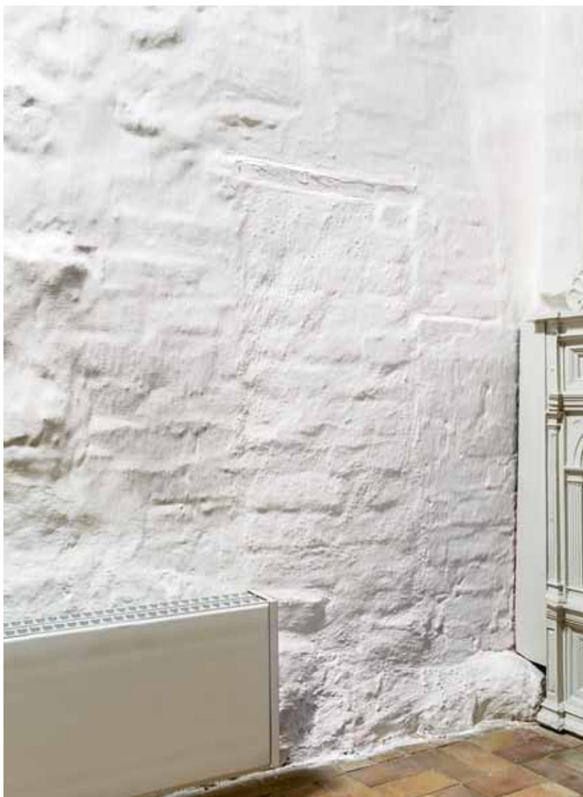
Fig. 50. Muret niche i koret nordvæg (s. 3665). Foto Arnold Mikkelsen 2015. – Masonry niche in north wall of chancel.
