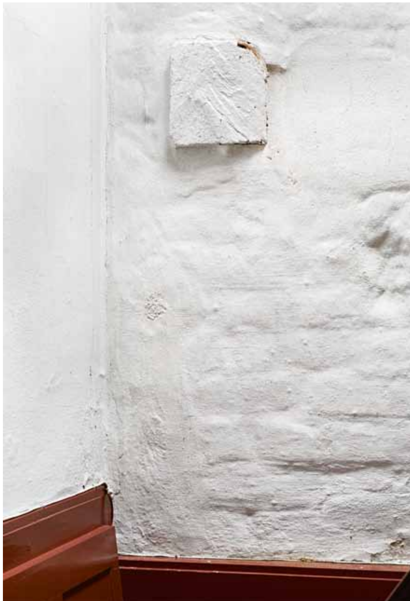
Fig. 49. Afsavet bjælke i tårnrummet (s. 3659). Foto Arnold Mikkelsen 2015. – Sawn-off beam in tower interior.
