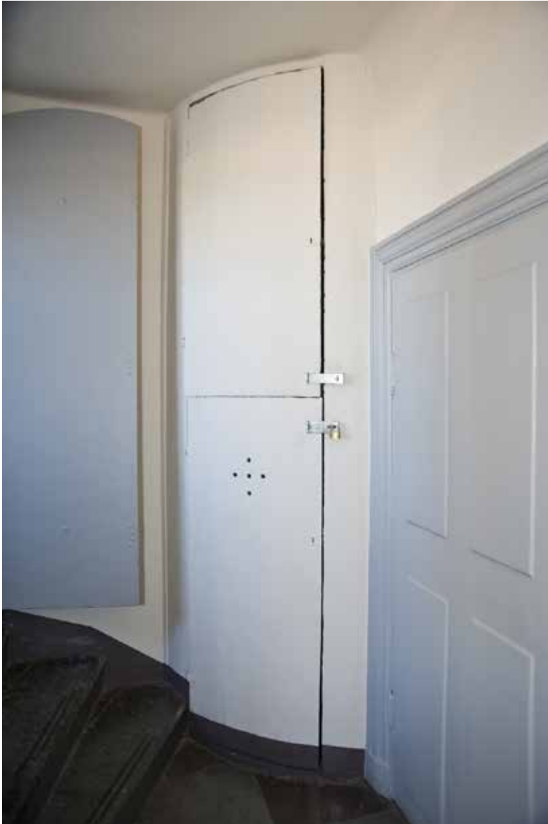
TILL HÖGER I BILD SES EN DÖRR MED FYRA UTANPÅLIGGANDE Fyllningar, franska gångjärn och profilerat dörrfoder, allt från 1700-talet. GATHUSETS TRAPPLOPP. FOTO: J. MALMBERG.
