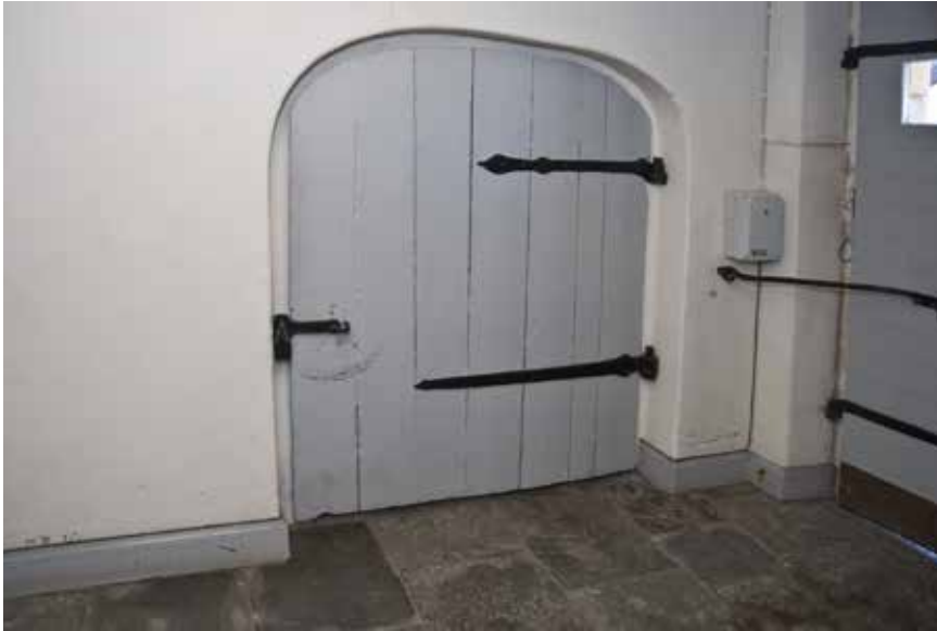
DEN LÅGA PLANKDÖRREN MED SMIDDA BANDGÅNGJÄRN FINNS I PORTGÅNGEN VID PRYSSGRÄND. FOTO: J. MALMBERG.
