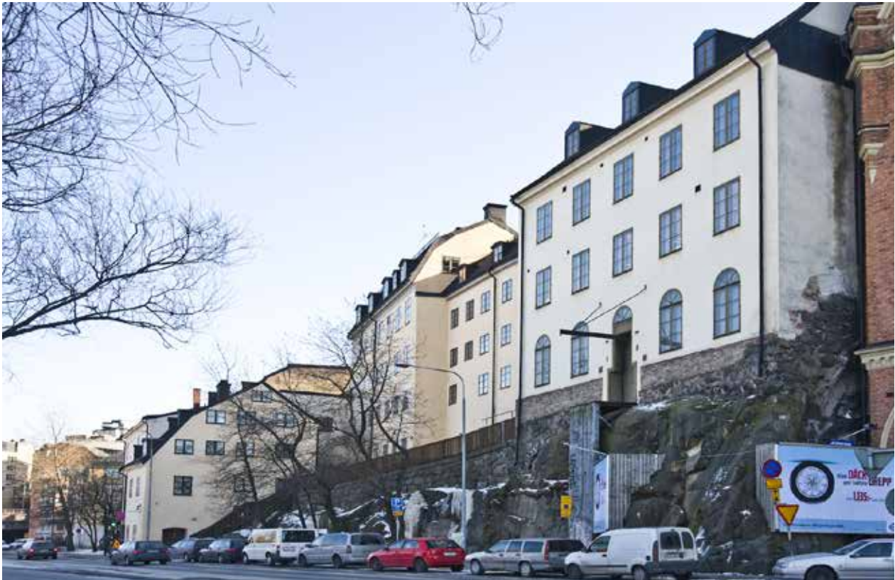
FASADER MOT SÖDER MÄLARSTRAND. NÄRMAST I BILD MED HISSBOM ÄR VERKSTADSHUSET FRÅN 1852. BAKOM GÅRDENS TRÄSTAKET RESER SIG DE TVÅ GATHUSEN FRÅN 1700-TALET. NEDERST, VID SÖDER MÄLARSTRAND, SES GÅRDSHUSET SOM ÄR BEVARTAT FRÅN FÖRE MARIABRANDEN 1759. FOTO: J. MALMBERG.
