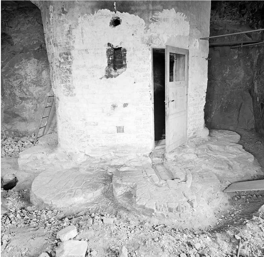
SÖDER MÄLARSTRAND 19. FUNDAMENT FÖR ELDSTÄDER, SANNOLIKT ANVÄNDA I FÄRGERIVERKSAMHETEN, PÅTRÄFFADES VID RENOVERINGEN PÅ 1970-TALET. FOTO: L. AF PETERSENS 1971, SSM F99053.
