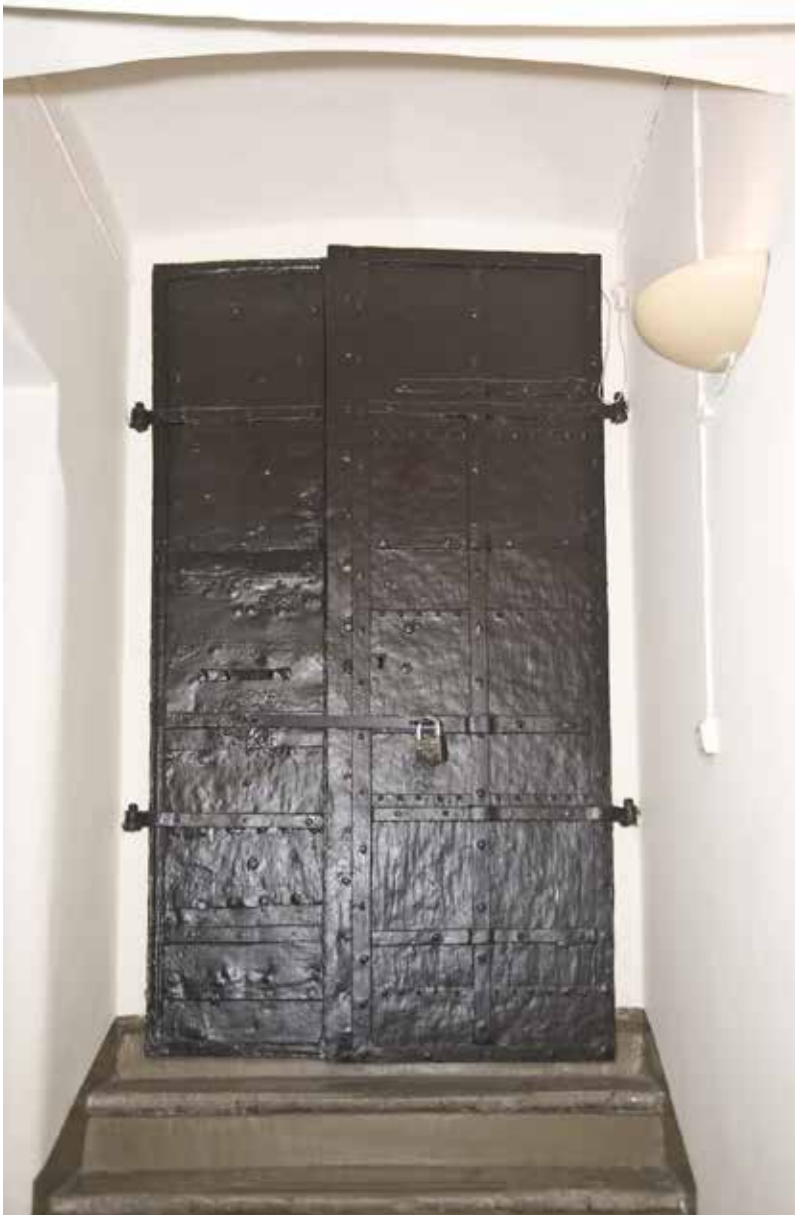
ÄLDRE SMIDD JÄRNDÖRR TILL VINDEN I TRAPPHUSET 10 B. FOTO: J. MALMBERG.
