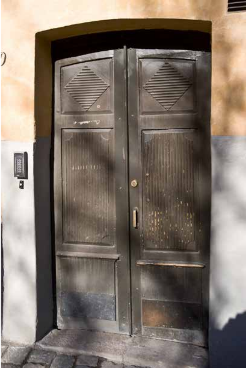
PORTEN VID PRYSSGRÄND MED EN PARDÖRR FRÅN 1700-TALETS SLUT OCH EN ÄLDRE TRÖSKELSTEN. FOTO: J. MALMBERG.
