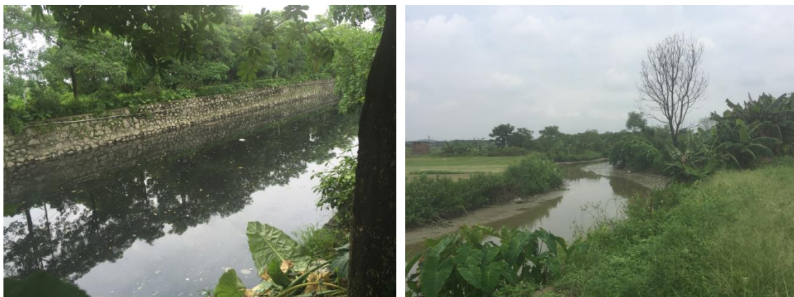
图 2.1-14 场内渠道现状图
