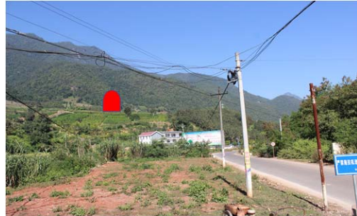
图 4.6.4-2 大窝子隧道出口概貌
