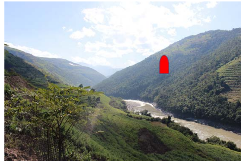
图 4.6.4-5 干湾塘隧道出口概貌
