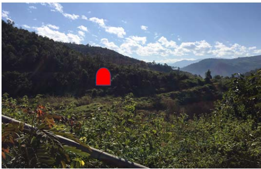
图 4.6.4-4 干湾塘隧道进口概貌
