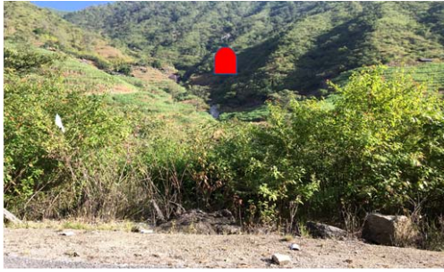
图 4.6.4-1 大窝子隧道进口概貌
