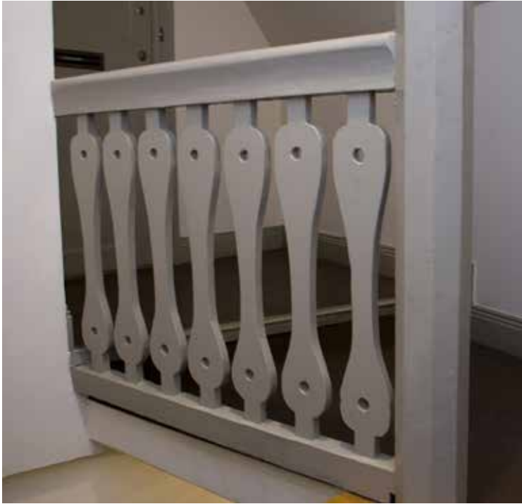
ETT AV TRAPPHUSEN I 1700-TALSBYGGNADEN BEVARAR ETT ÄLDRE DEKORATIVT RÄCKE. FOTO: J. MALMBERG.
