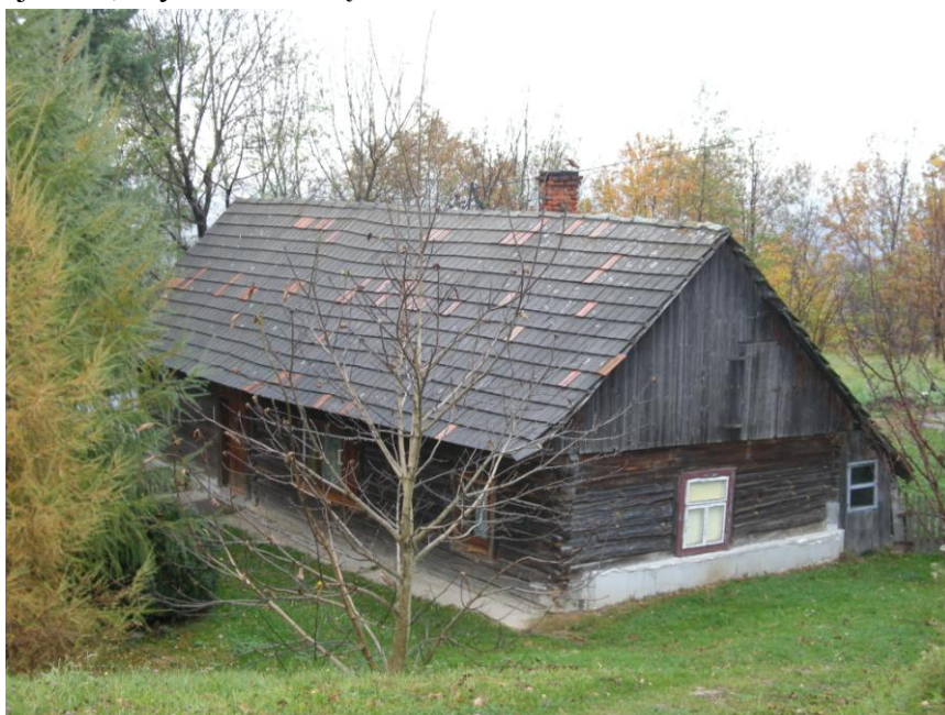
Dom mieszkalny nr 99 w Dąbrówce Szczepanowskiej z 1900 r.
