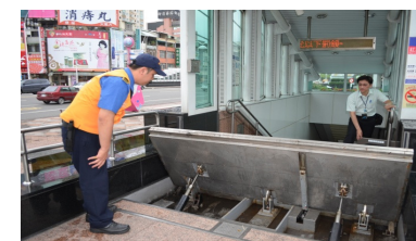
防洪擋板架設(項次 2)
