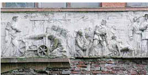
Элемент цементного фриза
