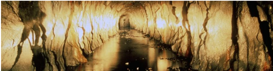
Figur 5-4. Interiörbild från Bolmentunneln. Tunneln är i normalfallet helt vattenfylld och bilden är tagen då tunneln delvis tömts för att möjliggöra underhållsarbete. Bildkälla: Syd-vatten.
