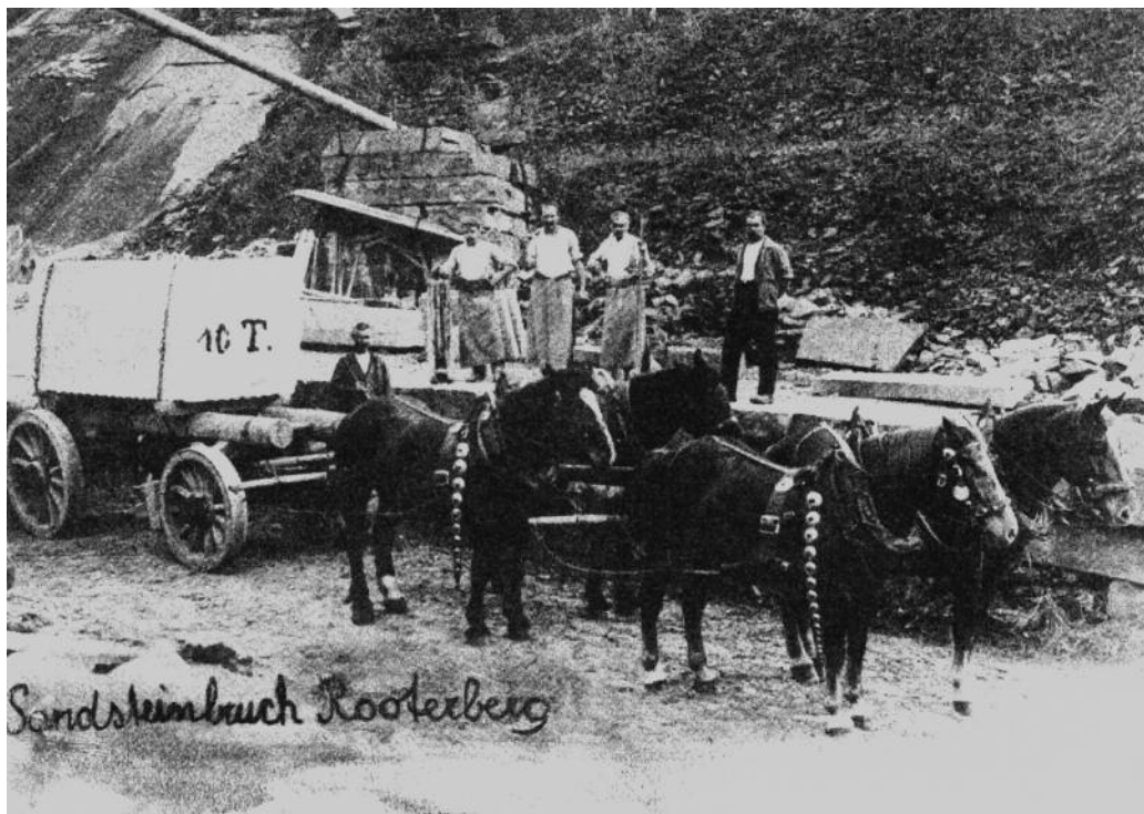
Der grösste, schwierigste, imposanteste und auch letzte Transport eines Steinblocks von 10 Tonnen gewicht, der mittels Wellenbock und Winden direkt ab Wiesbruchverladen und ab Gisikon ins Tessin geliefert wurde (im Sommer 1927). Dabei waren Karl Herzog, Oberfeld August Bründler, genannt "Stis", Dierikon Dominik Meier, Krapfenmatt, und Ruedi Thali, Unterdorf
