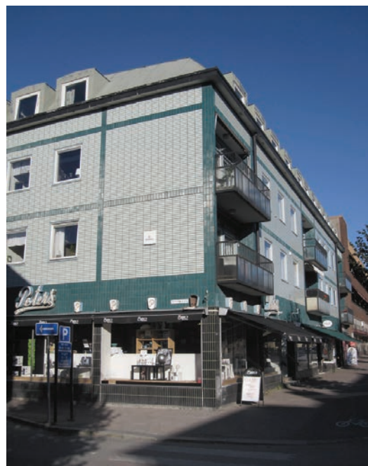
Lunden 11 har många tidstypiska detaljer från 1950-talet, så som fasadbeklädnaden av kakel och klinkers.
