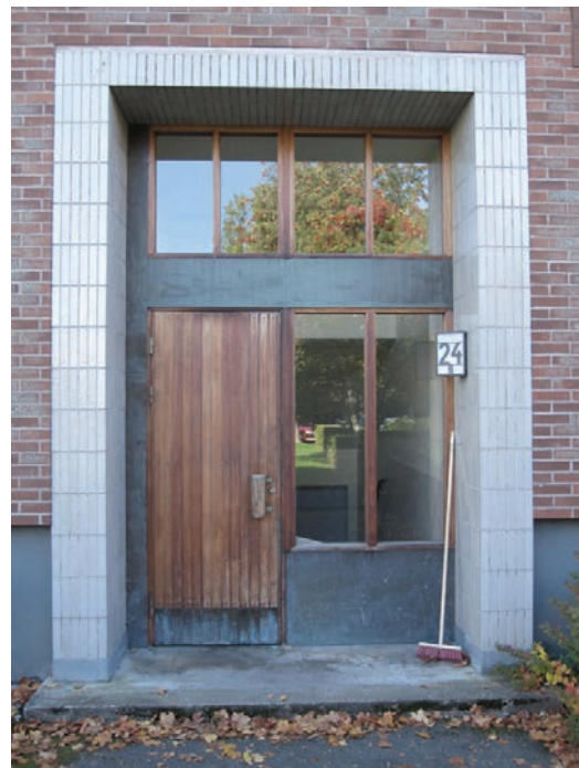
Leoparden 13 har bevarade originalportar och armaturer vid entrén.
