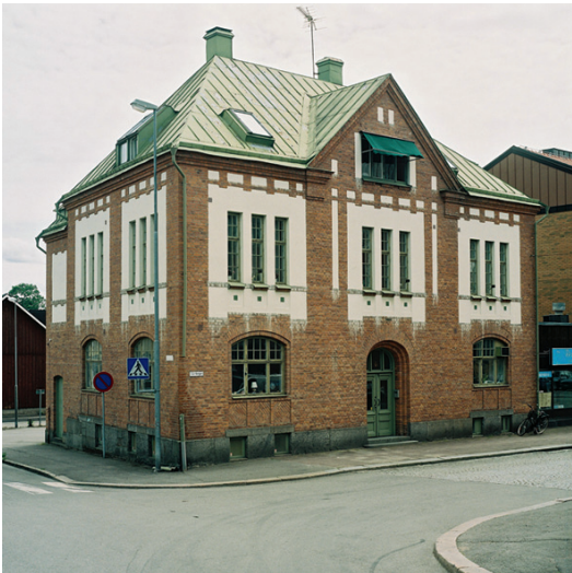
Det första stadshuset är väl bevarat från byggtiden. Tegelfasaden med de ljusa putsade partierna och dekorativt nyttjade kakelplattorna återkommer i flera av Atterströms byggnader från denna tid.
