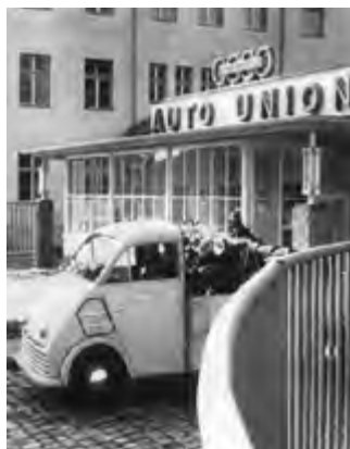
FACTORY GATE IN INGOLSTADT
