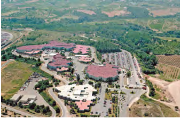
CENTRO TECNICO IN MARTORELL
