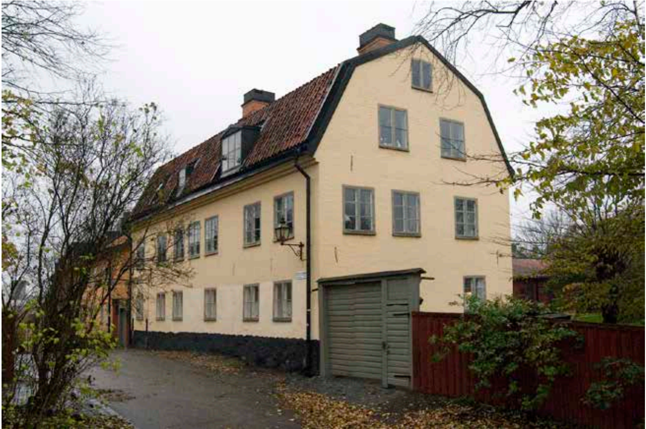
FASADEN MOT GATAN MED NORRA GAVELN NÄRMAST. FOTO J. MALMBERG.
