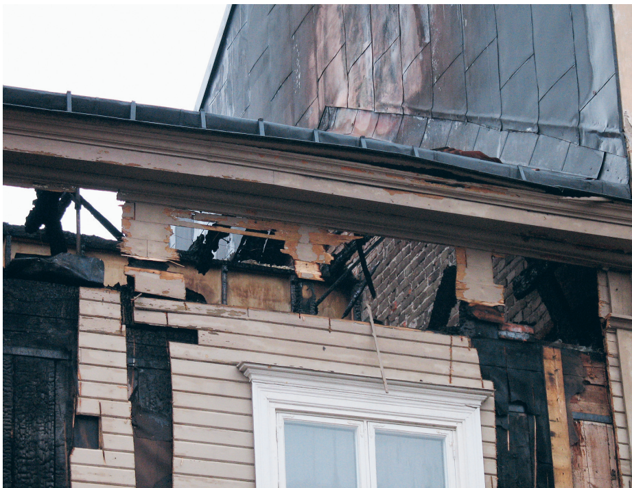
En brandmur mellan byggnader som fungerat.
