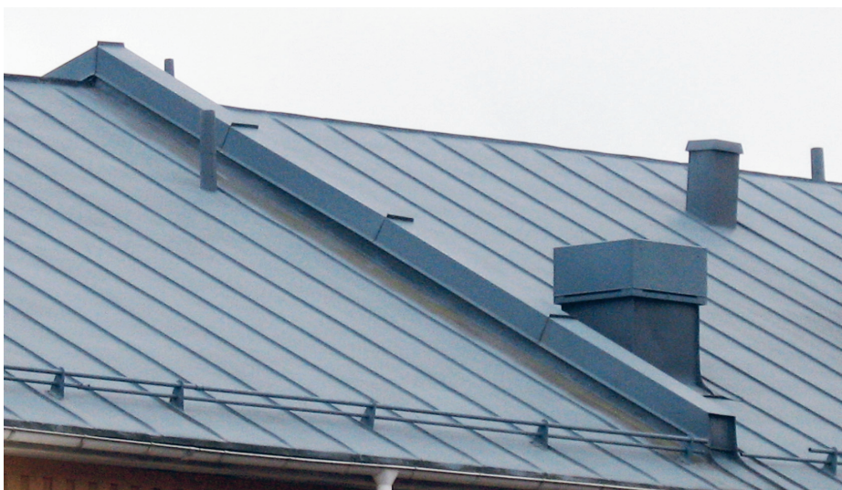
Äldre synlig brandmur som passerar takvirket.
