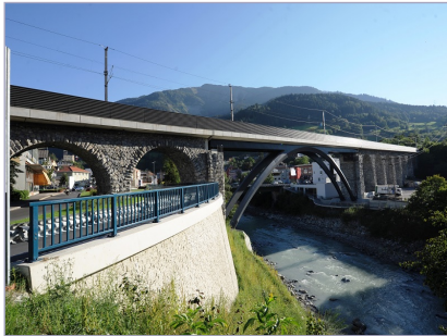
Innbrücke - Ansicht von Süden
