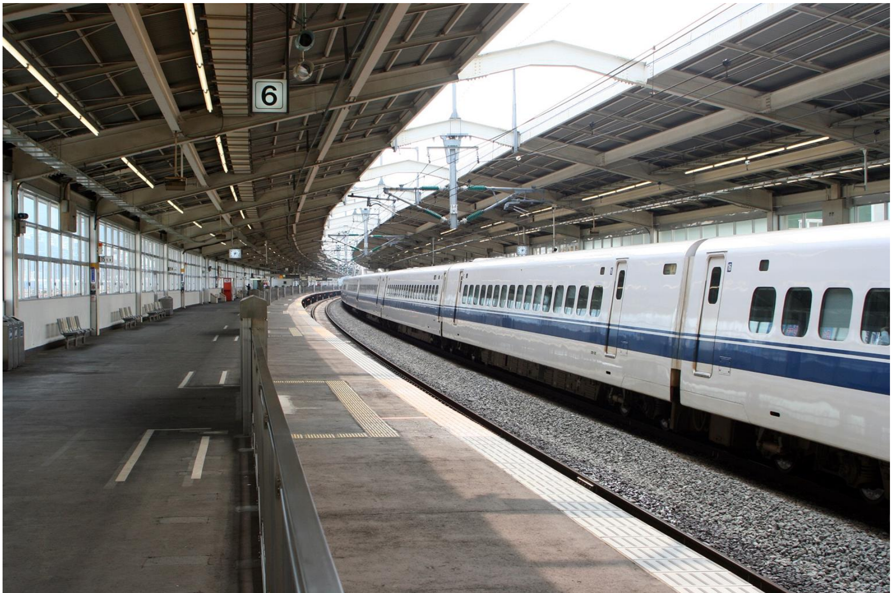
急カーブの途中に設けられた東海道新幹線の熱海駅
