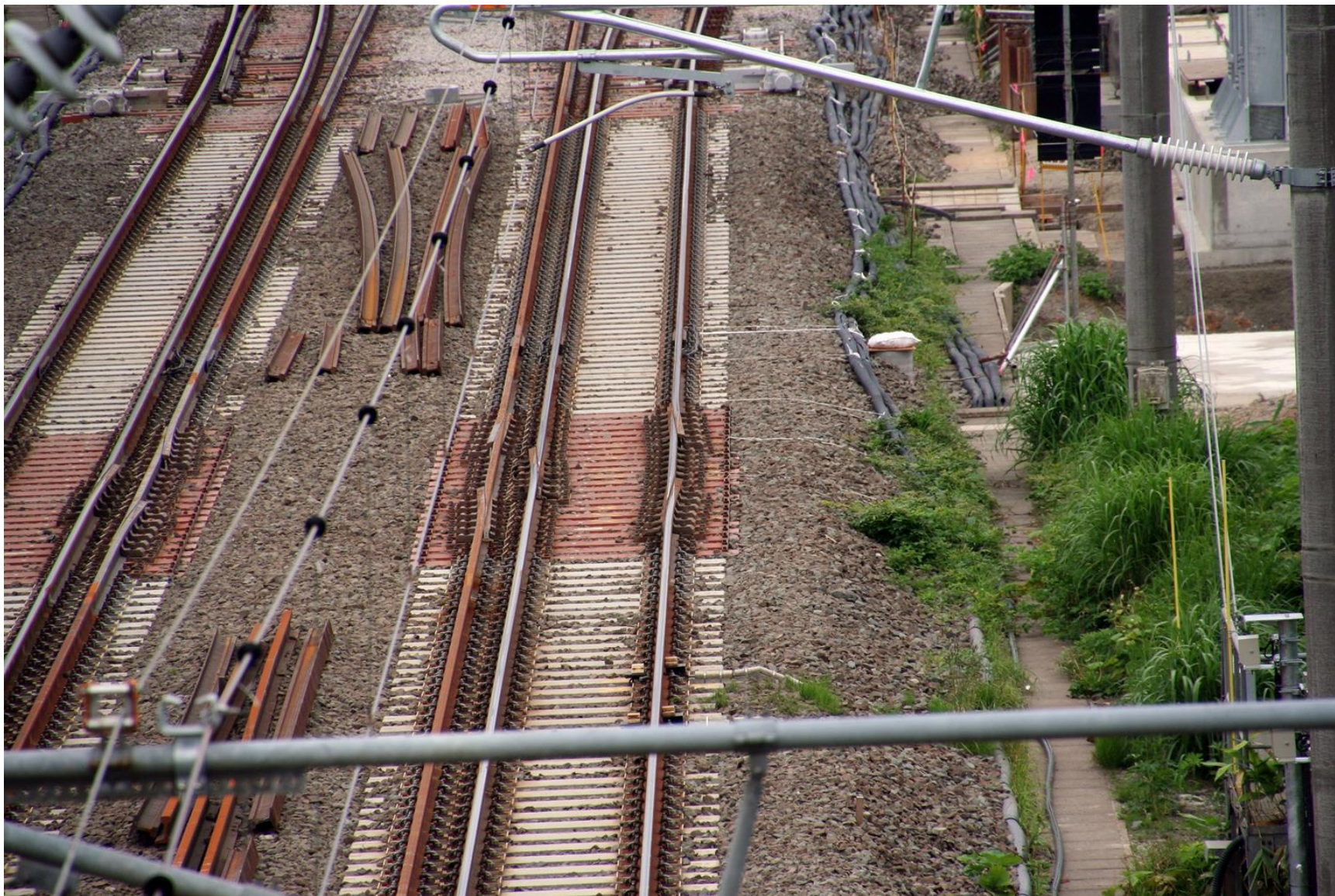
フル規格新幹線と在来線とが線路を共用する北海道新幹線の青函トンネル付近の区間
