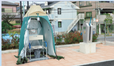
マンホールトイレの設置例、井戸(右)を利用して水を流します
