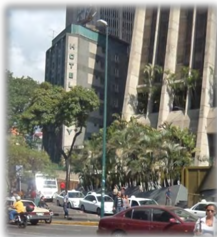
Imagen2. 39 Poste de Iluminación Vehicular. Sector Plaza Venezuela
