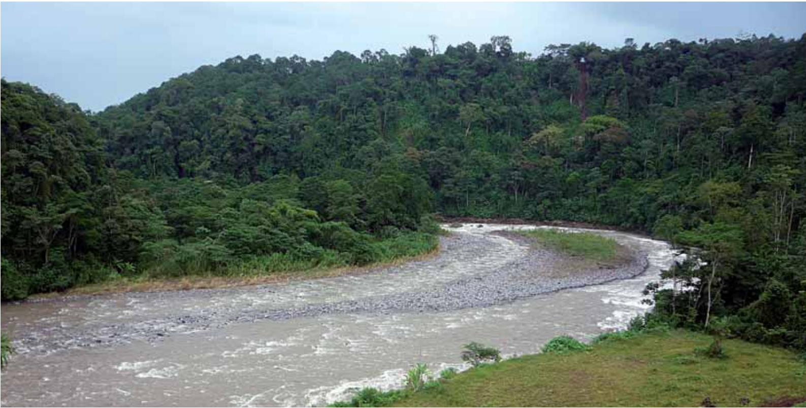
▲ Standort für das Wasserkraftwerk Reventazón, Costa Rica
