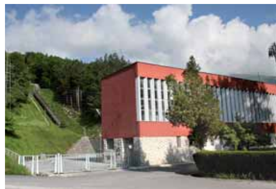
▲ Wasserkraftwerk Raven, Mazedonien
