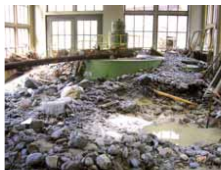
▲ Wiesberg, Österreich – vor der Sanierung
