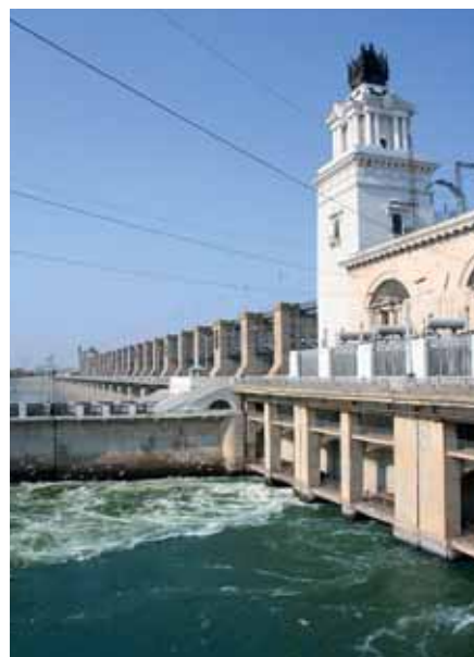
▼ Tsimlyanskaya Wasserkraftwerk, Russland
