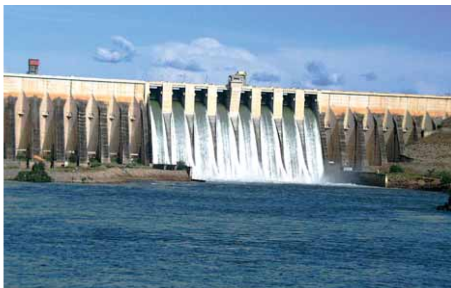
▼ Wasserkraftwerk Manantali, Mali
