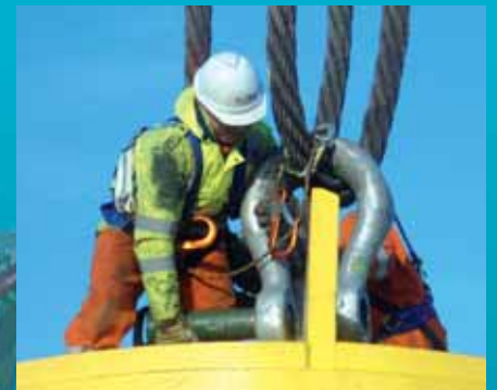
▲ Installation der Ballastgewichte
