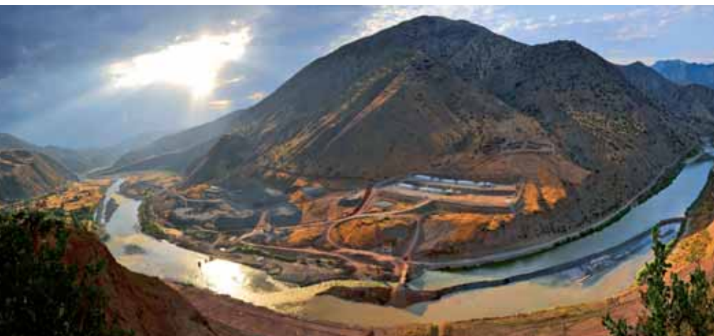
▼ Aktuelle Baustellenarbeiten am Murat-Fluss, Türkei
