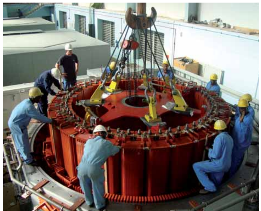
▼ Anheben eines Rotors im KW Kindaruma, Kenia
