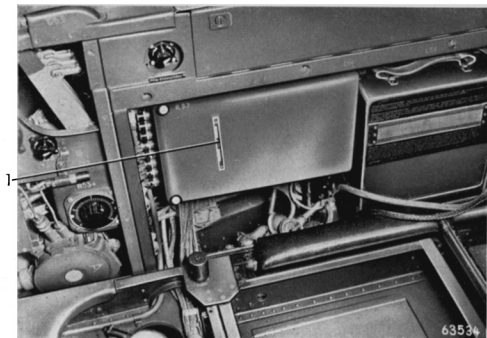
Abb. 26: RAB-14 d-Unterteil eingebaut
