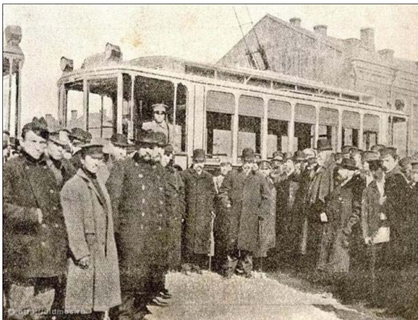
Открытие новой ветки электрического трамвая
