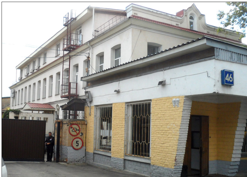
То же здание, вид сзади – надстроен третий этаж. Под №46 вход в типографию «НОВОСТИ»
