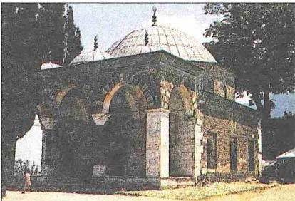
I. Bayezid'in türbesi - Bursa
