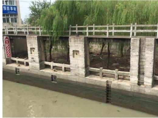
图 2.1-13 裕溪一线船闸闸墙
