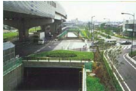
完成:平成5年6月
