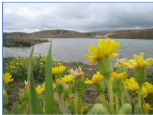
Barrage de Charef
